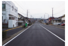
▲修繕工事後の青葉区内の道路
