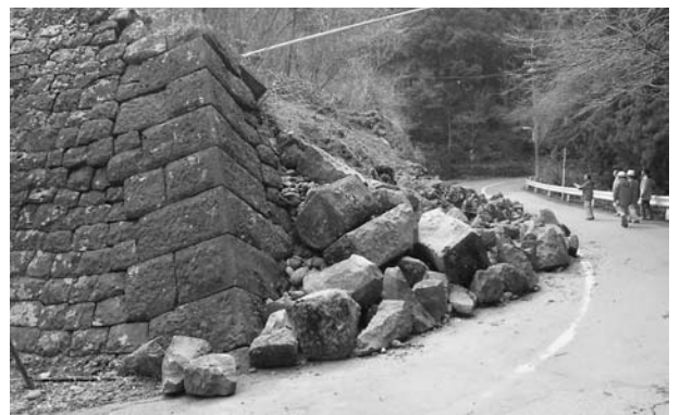
●本丸北西石垣の被災状況 (北から)
