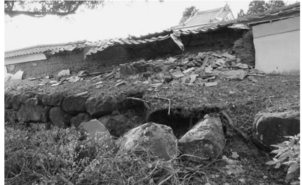
●大手門北側土塀の被災状況（北から）
