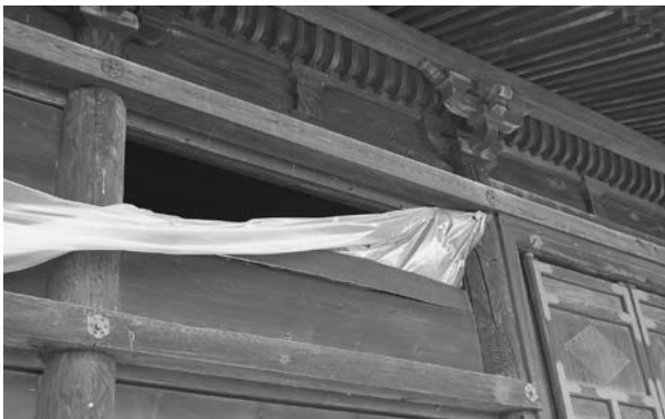
●陸奥国分寺薬師堂の被災状況
