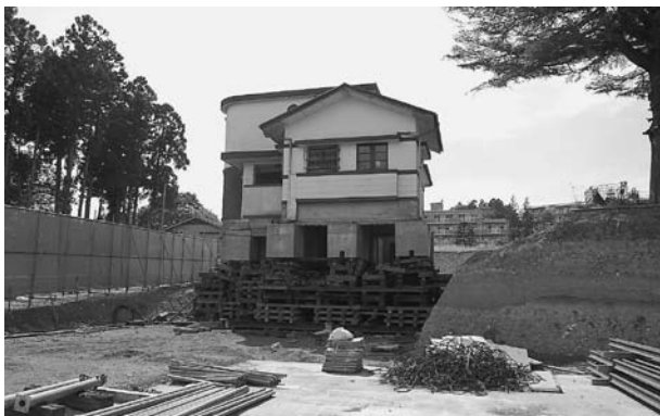
●荒巻配水所旧管理事務所の被災状況 1
