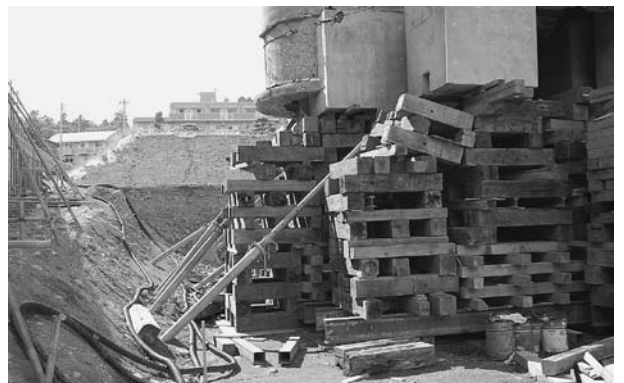
●荒巻配水所旧管理事務所の被災状況 2
