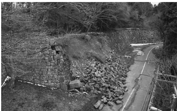
●本丸北西石垣の被災状況 (北から)
