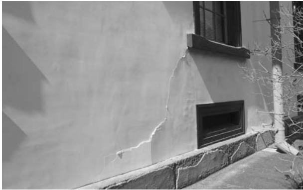
●旧第四連隊兵舎の被災状況（外壁）
