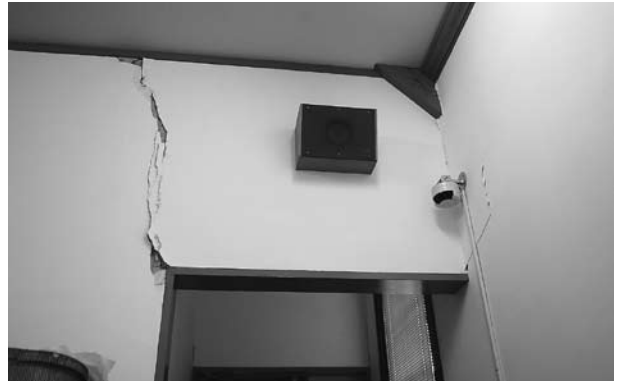
●旧第四連隊兵舎の被災状況（内壁）
