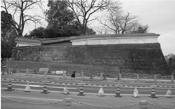
●大手門北側土塀の被災状況（南から）
