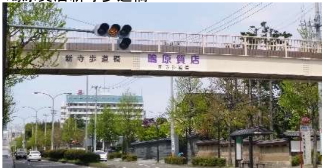
鳴原質店新寺歩道橋
