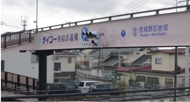
サイコー岩切歩道橋
