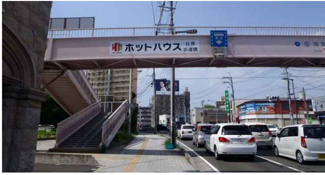
ホットハウス台原歩道橋
