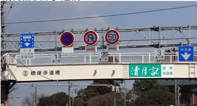
清月記根岸歩道橋
