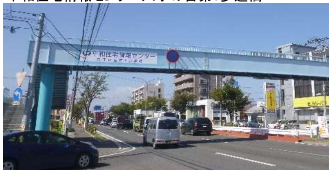
平和住宅情報センター六丁の目第1歩道橋
