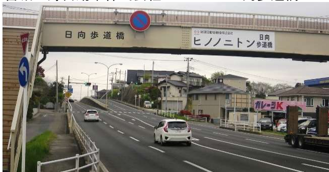
宮城日野自動車株式会社ヒノニトン日向歩道橋
