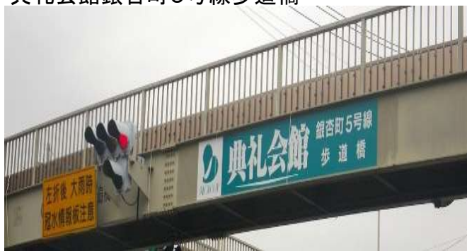
典礼会館銀杏町5号線歩道橋
