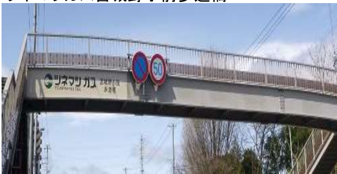
ツネマツガス宮城野小前歩道橋
