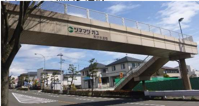
ツネマツガス燕沢歩道橋
