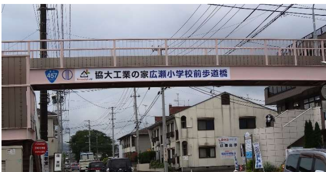
協大工業の家広瀬小学校前歩道橋
