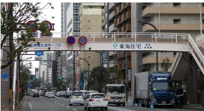
東海住宅通町歩道橋
