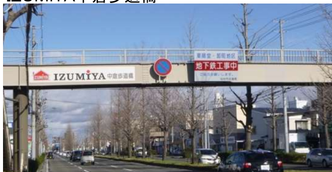
IZUMIYA中倉歩道橋
