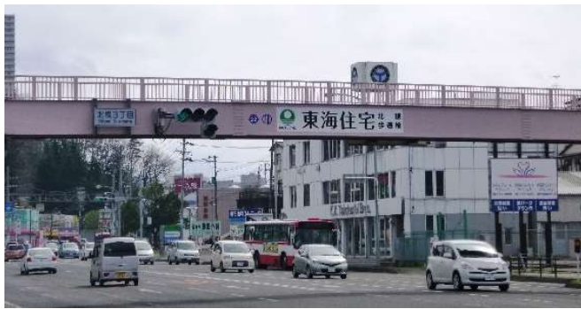
東海住宅北根歩道橋
