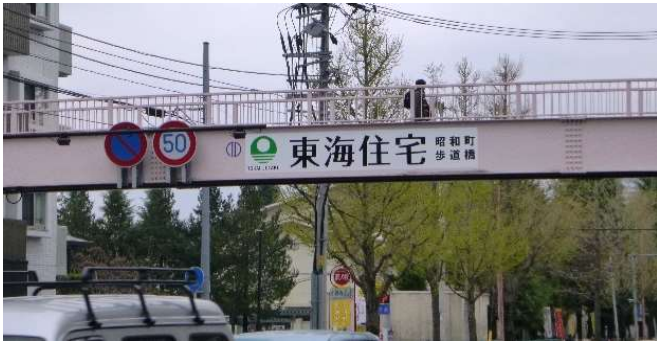
東海住宅昭和町歩道橋
