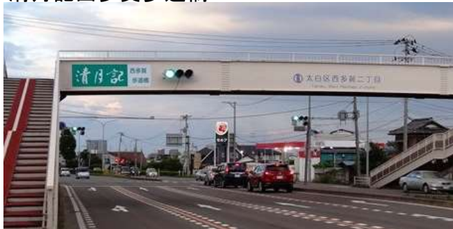
清月記西多賀歩道橋
