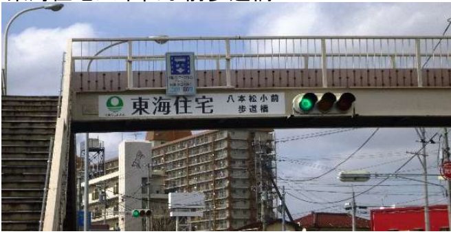
東海住宅八本松小前歩道橋
