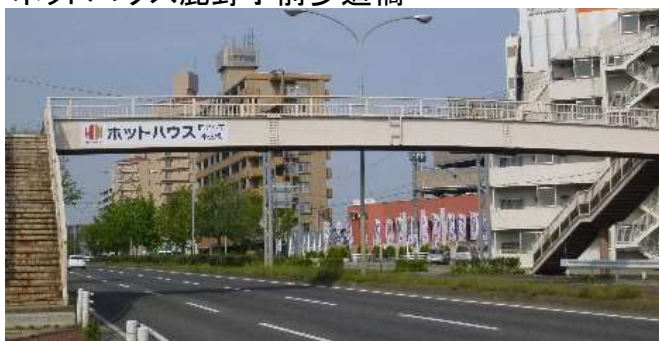
ホットハウス鹿野小前歩道橋
