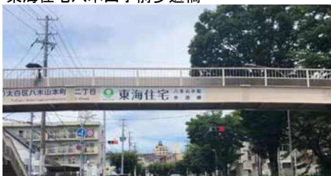
東海住宅八木山小前歩道橋
