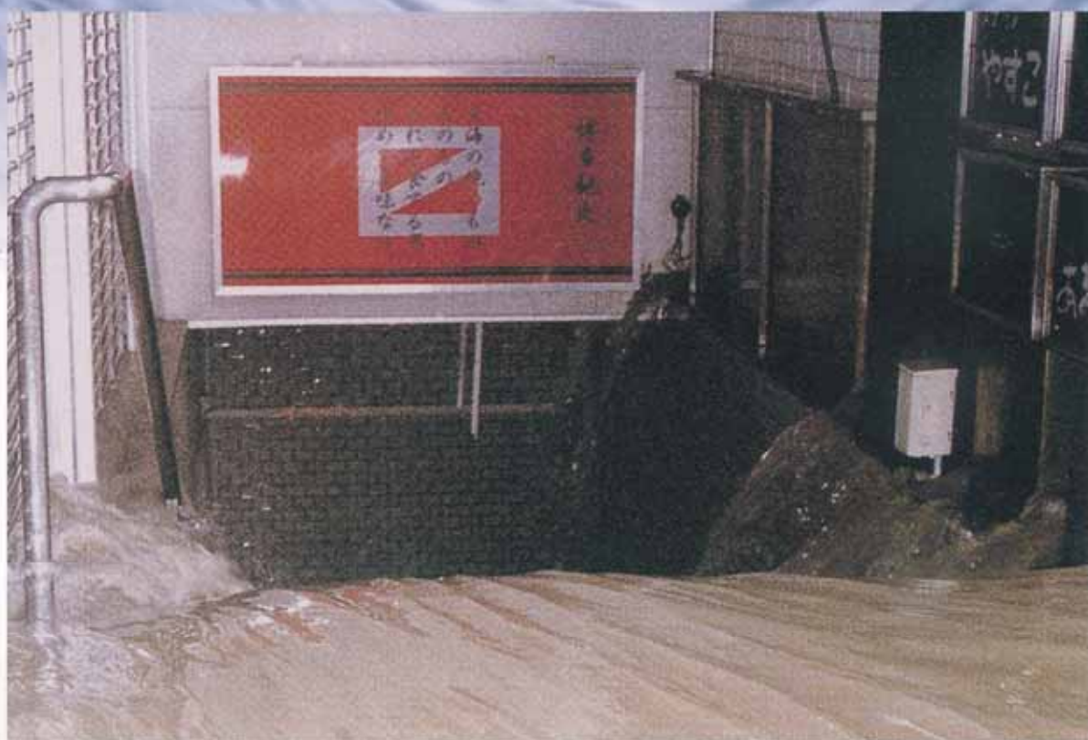
▲福岡市内 ビル地下入り口 (平成11年6月29日)
