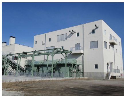
平成 31 年 3 月 鶴巻ポンプ場工事
