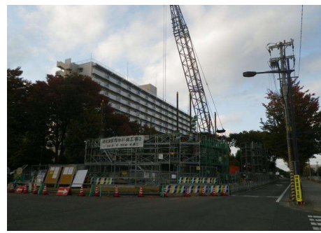
平成 27 年 10 月 No.2 立坑 (幹線工事 2)
