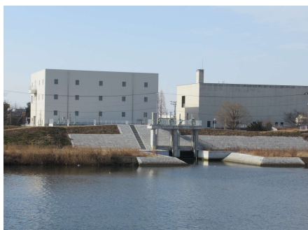
平成 31 年 3 月 鶴巻ポンプ場工事
