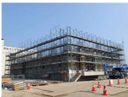
平成 29 年 6 月 鶴巻ポンプ場工事
