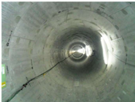
平成 30 年 3 月 内面仕上状況 (幹線工事 1)
