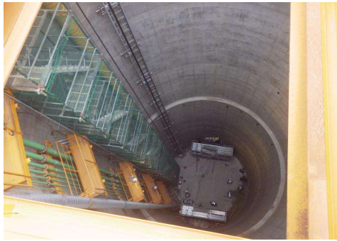
平成 27 年 9 月 No.3 立坑 (幹線工事 1)
