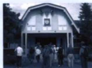
市内に唯一残る木造校舎 根白石小学校
