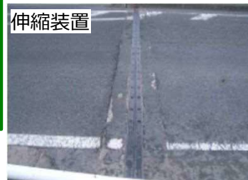
伸縮装置取替
