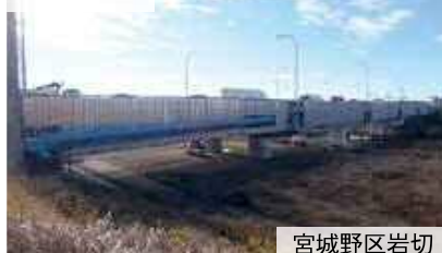
鋼桁再塗装、防水工等
