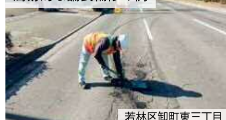
簡易的な舗装補修の例
