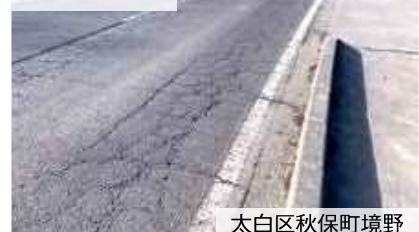
路盤の改良、舗装の打替え等
