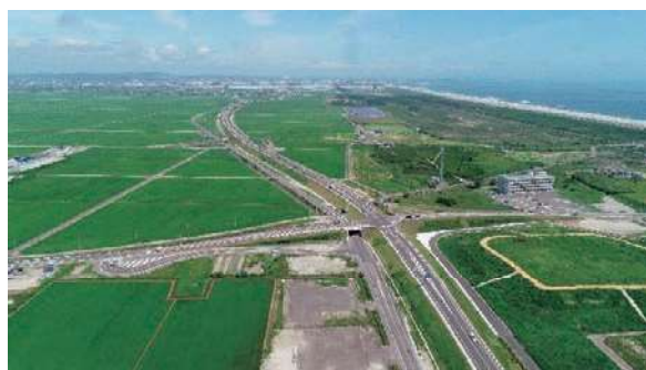
【東部地区に整備されたかさ上げ道路】
