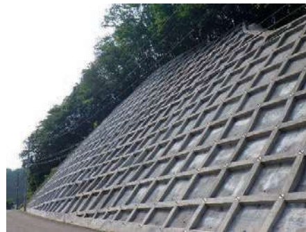
【道路法面の防災対策】
