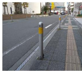
防護柵等の設置（ボラード）
