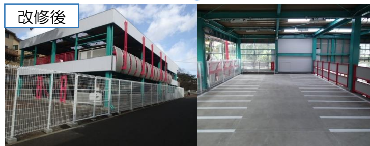
図20 黒松駅駐輪場 大規模改修
