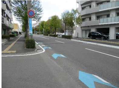
あんしん通行路線の整備例 (仙台市・市道七北田実沢線)
