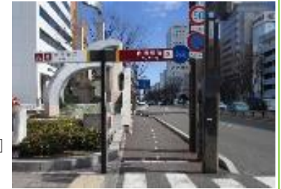
自転車道線の整備事例 (市道宮城野通線)
