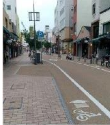
無電柱化と合わせた通行空間の整備 (愛媛県松山市)
