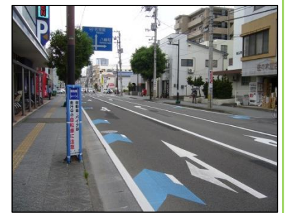
車道走行の整備事例 (市道宮町通線)
