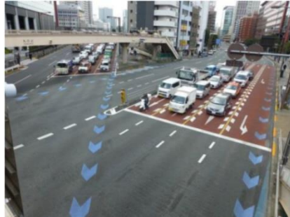
自転車ナビラインの設置と左折車との交錯を避けた現示調整を行った例 (東京都港区・札の辻交差点)
