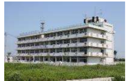
震災遺構 仙台市立荒浜小学校
