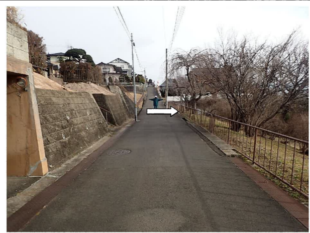
P3_盛土中腹部の道路および擁壁に変状なし
