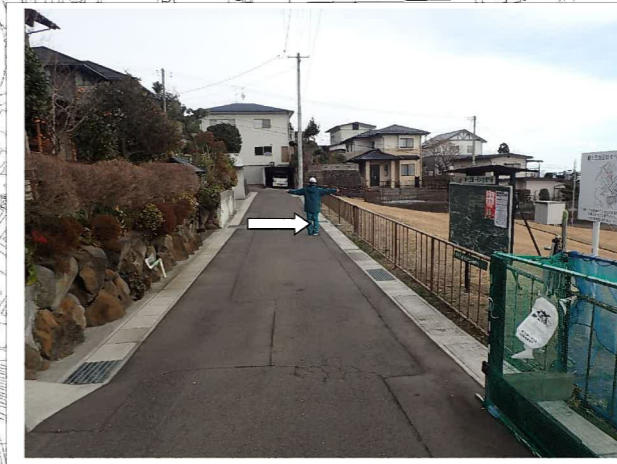
P4_盛土頭部の道路および側溝に変状なし
