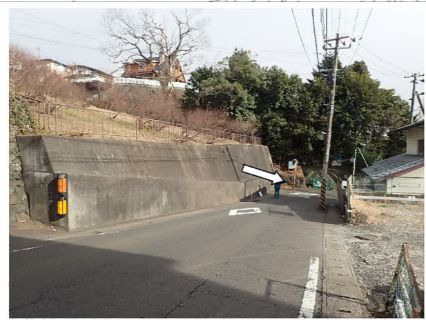
P1_盛土末端部全景
