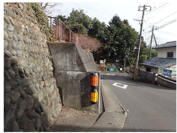
P2_盛土末端部の擁壁および道路に変状なし
