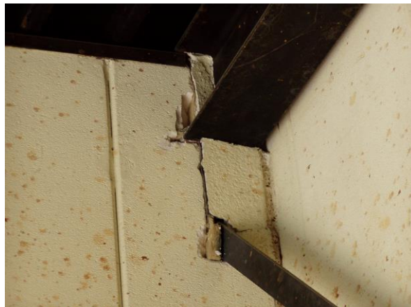
写真 2-2-22 管理棟工作室入口の亀裂状況
