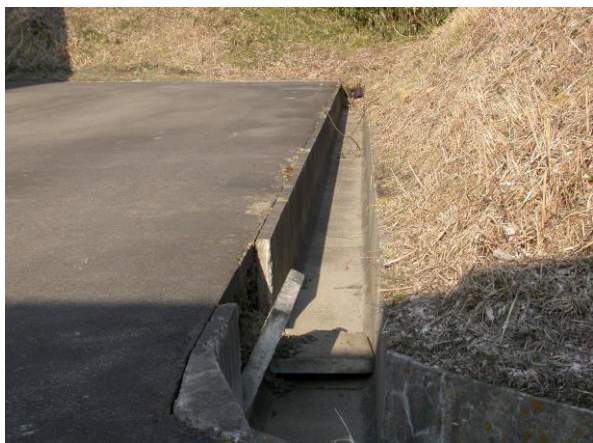
写真 2-2-25 施設外周側溝の崩壊状況
