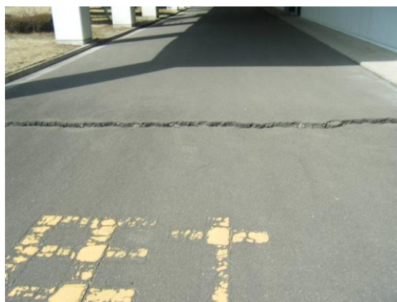
写真 2-2-1 舗装の段差発生状況
