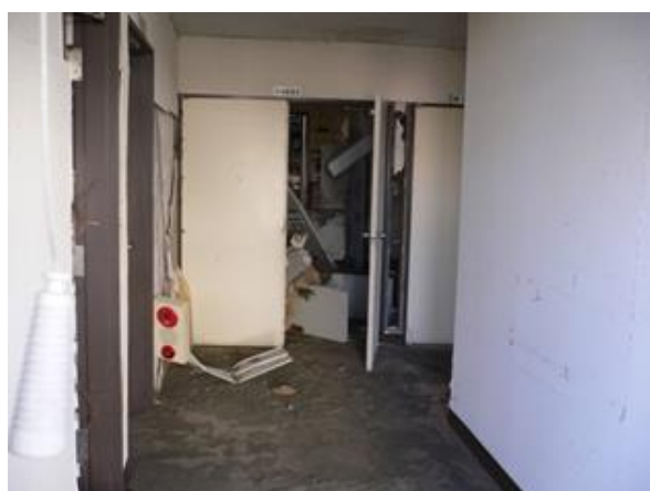
写真 2-2-42 建物内（入口周辺）の被害状況
