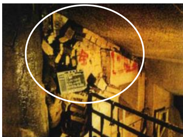
写真 2-2-6 焼却炉内耐火物脱落状況
