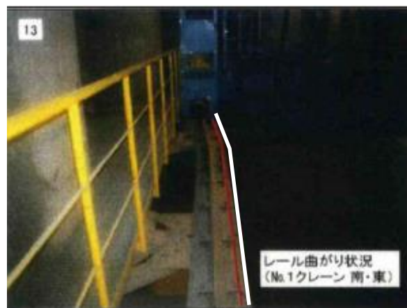
写真 2-2-5 ごみクレーン変形（曲がり）状況
