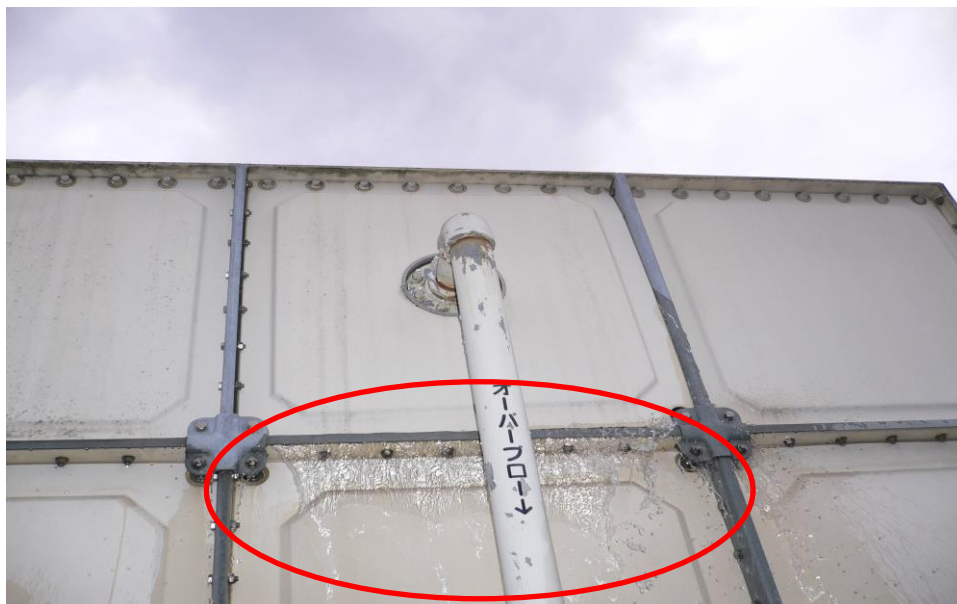
写真 2-2-26 受水槽水漏れ状況
