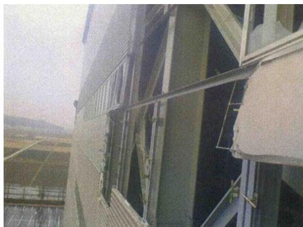
写真 2-2-19 余震（4月7日）による 外壁損傷状況
