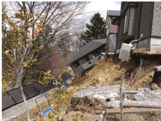
写真 2-1-3 宅地被害状況 (青葉区西花苑)
