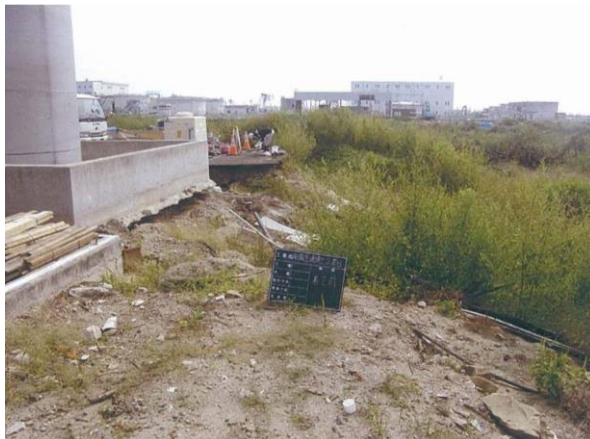
写真 2-2-32 敷地盛土の流出状況
