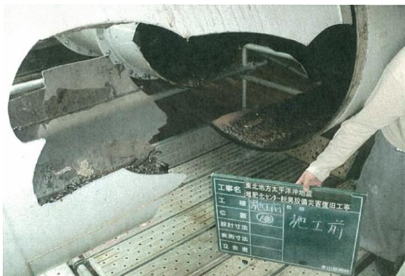
写真 2-2-27 脱臭設備の損傷状況
