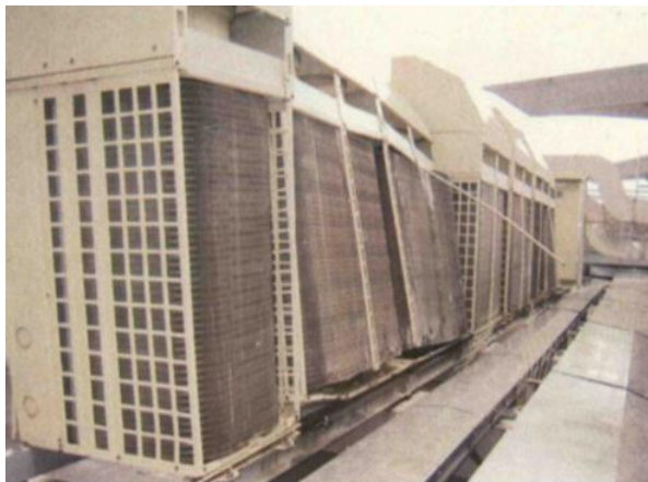
写真 2-2-16 空調屋外機損傷状況
