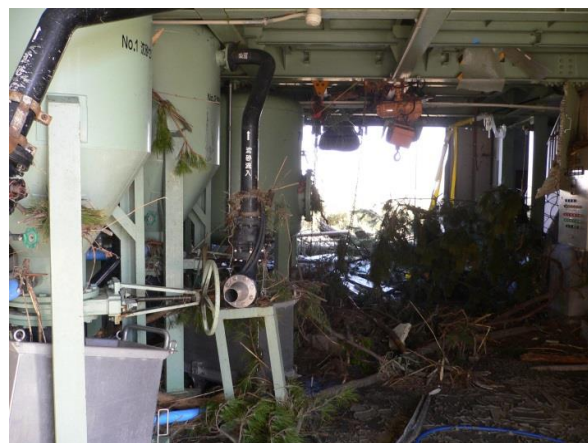
写真 2-2-38 建物内（灰ホッパ下通路）の被害状況
