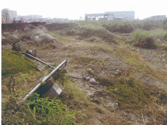
写真 2-2-31 敷地盛土の流出状況
