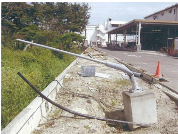
写真 2-2-33 囲障施設の流出状況
