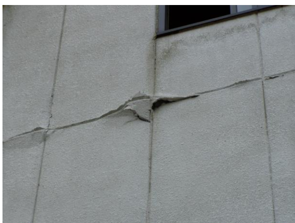
写真 2-2-24 第二排水処理施設外壁の 損傷状況
