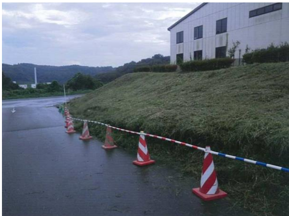
写真 2-2-29 法面崩落状況
