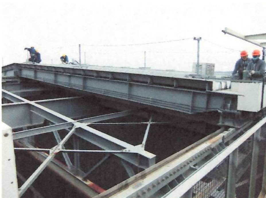
写真 2-2-3 可動屋根の点検状況
