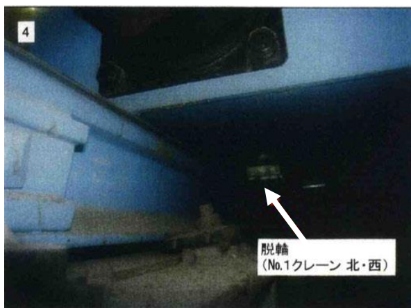
写真 2-2-4 ごみクレーン脱輪状況
