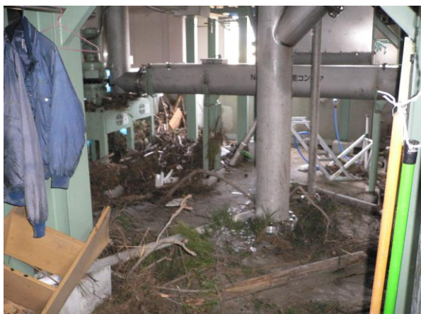
写真 2-2-39 建物内（脱水機室）の被害状況
