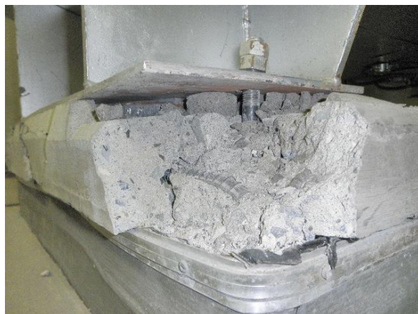
写真 2-2-13 機器設備基礎損傷状況
