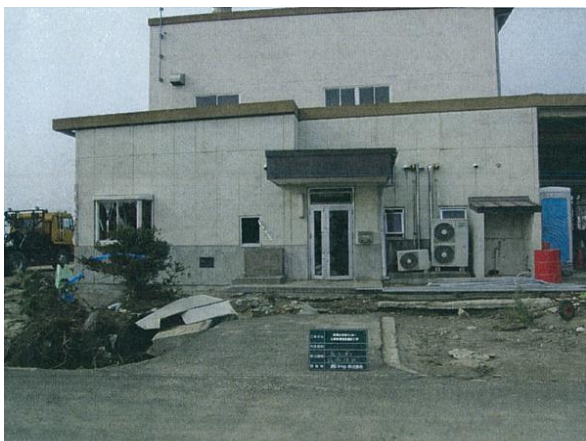
写真 2-2-35 建物の被害状況
