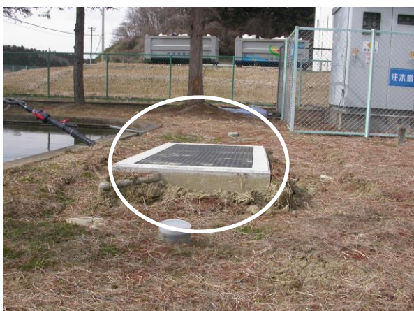
写真 2-2-23 管理棟浄化槽の隆起状況
