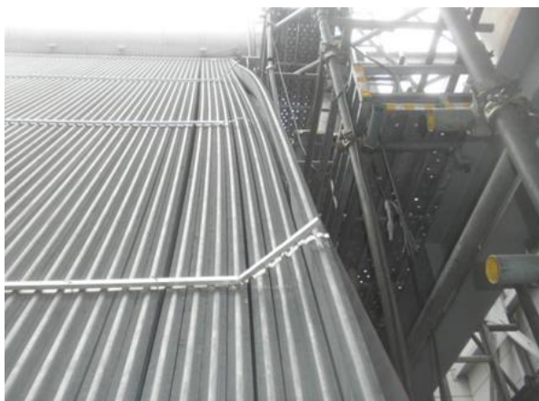
写真 2-2-10 蒸気復水器フィン損傷状況
