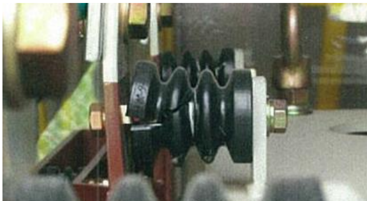
写真 2-2-20 変圧器の絶縁部品の破損状況
