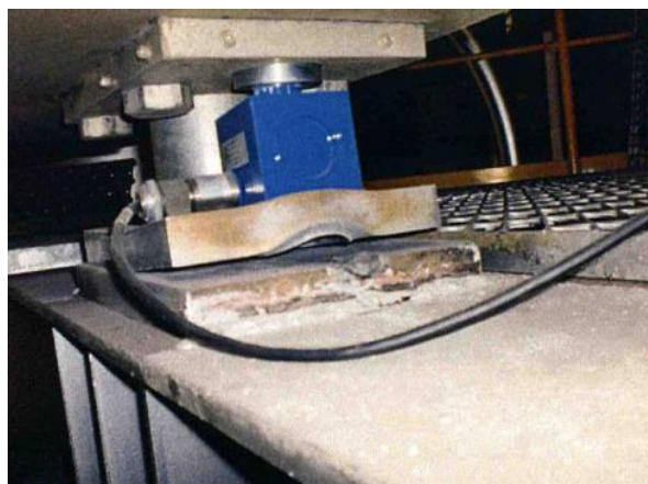
写真 2-2-11 消石灰サイロ荷重計 (ロードセル) 損傷状況
