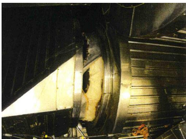
写真 2-2-12 煙道継手部損傷状況
