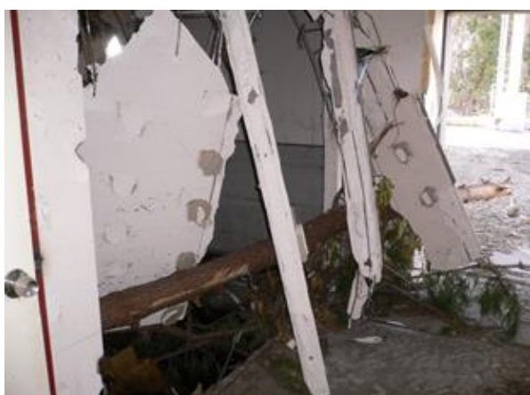
写真 2-2-41 建物内（地下ポンプ室へのホッパ周辺）の被害状況
