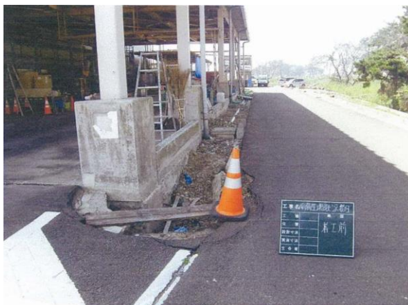
写真 2-2-34 排水構造物の流出状況
