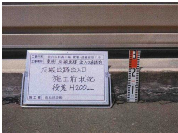
写真 2-2-17 焼却灰搬出路地盤沈下状況
