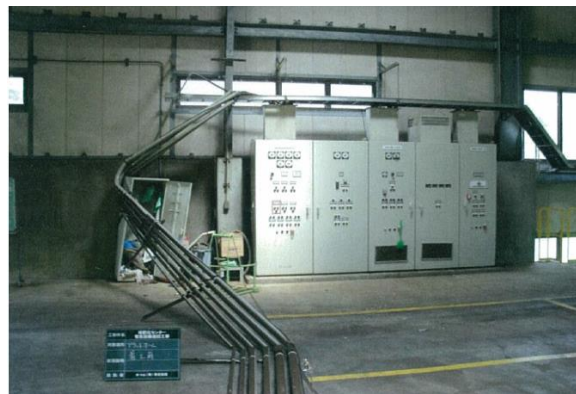
写真 2-2-28 電気設備の損傷状況
