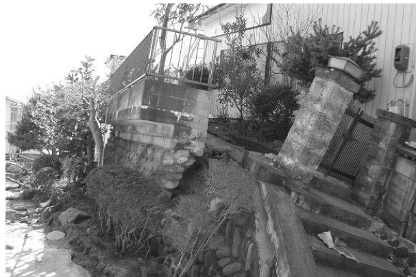
写真 2-1-4 宅地被害状況 (太白区青山)
