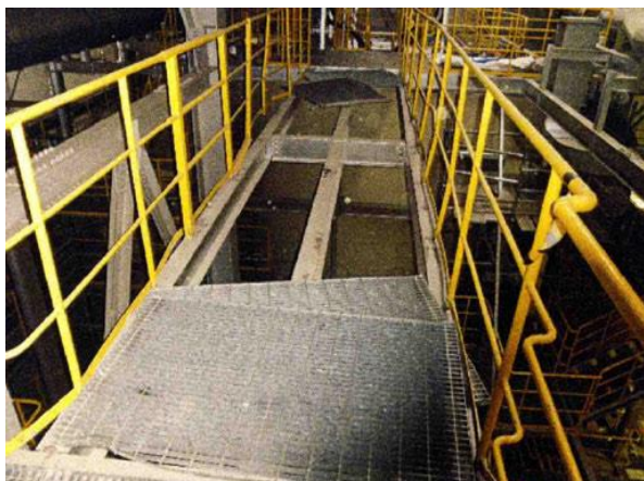
写真 2-2-14 点検歩廊損傷状況
