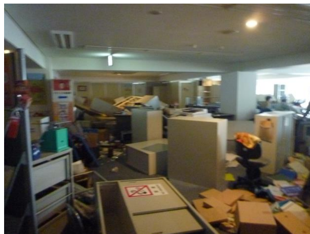
写真 2-1-6 執務室（環境局総務課・施設部周辺）の状況
