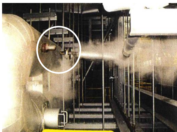
写真 2-2-8 配管破損による蒸気噴出状況
