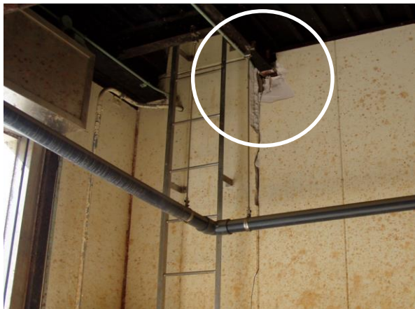
写真 2-2-21 管理棟工作室入口の亀裂状況
