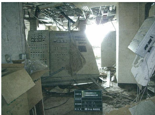
写真 2-2-37 建物内（中央制御室）の被害状況
