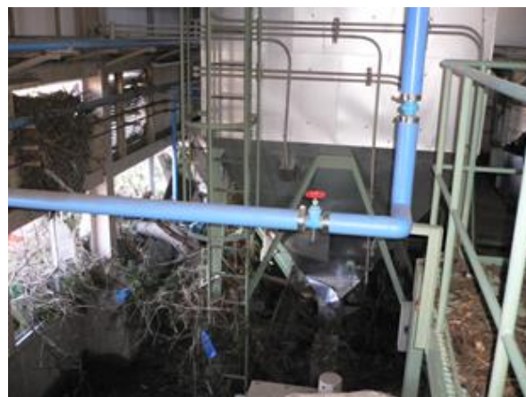
写真 2-2-40 建物内（焼却炉室内し渣階段周辺）の被害状況
