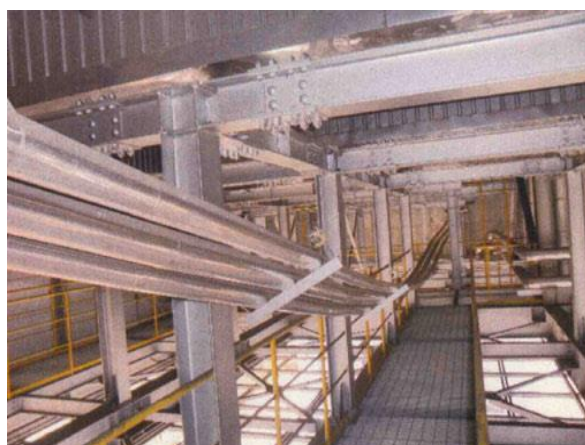
写真 2-2-9 配管脱落状況
