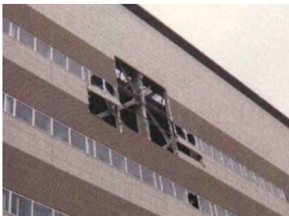
写真 2-2-18 余震（4月7日）による 外壁損傷状況
