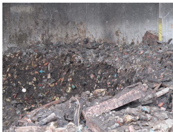
写真 5-2-4 倉庫 2階の状況
