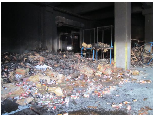
写真 5-2-3 倉庫 1階の状況
