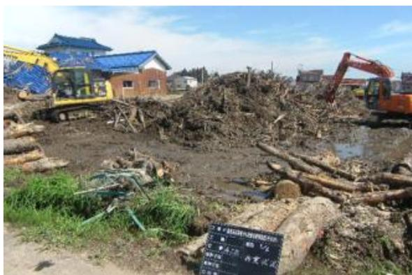
写真 7-2-9 農地の津波堆積物撤去
