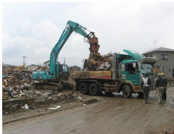
写真 7-1-4 集積されたがれきの搬出状況
