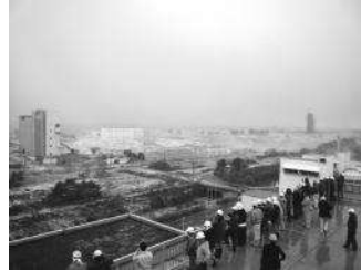
< 南蒲生浄化センター（宮城野区蒲生） >
