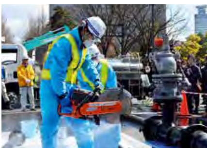
仙台市水道局による 応急復旧デモンストレーション
