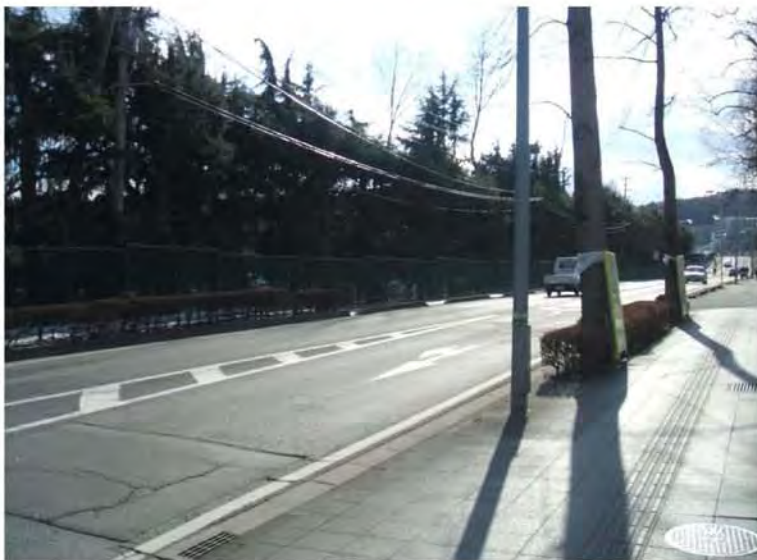
測定位置 (S-3') 付近状況
