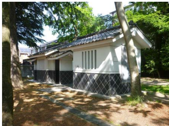
② トイレ (平成 28 年 5 月 22 日撮影)
