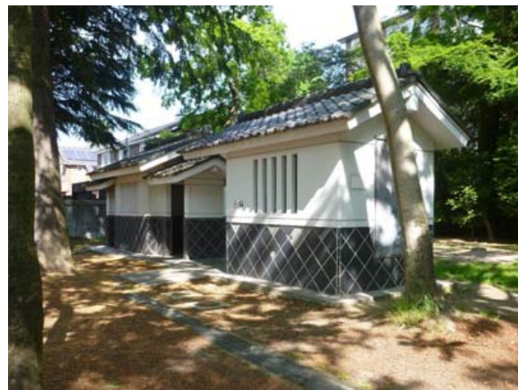
② トイレ (平成 28 年 5 月 22 日撮影)
