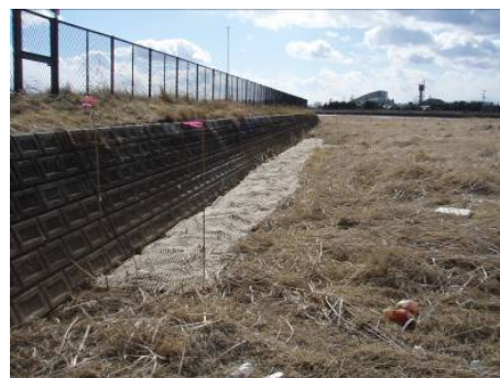
図 6-20 浮上防止ネット設置後の状況 （大沼）（平成 23 年 3 月 4 日撮影）
