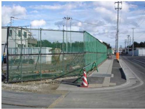
図 6-10 防塵ネット設置状況 (平成 25 年 11 月 28 日)
