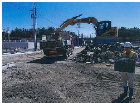
図 6-21 コンクリート殻積込状況 （平成 22 年 11 月 9 日撮影）
