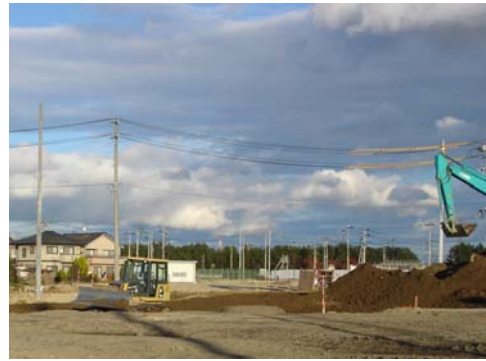
図 6-5 家屋近傍で小型ブルドーザの稼働 (平成 25 年 11 月 28 日)
