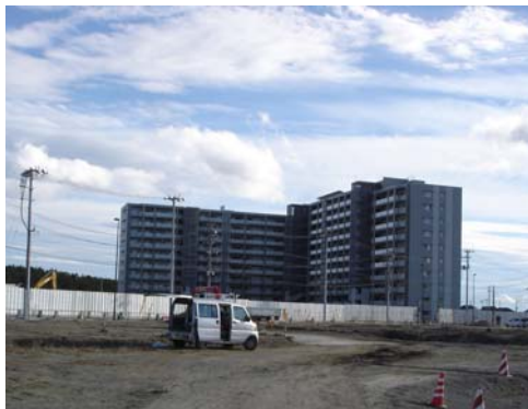
図 6-12 復興公営住宅防音防塵壁 (平成 23 年 2 月 8 日)
