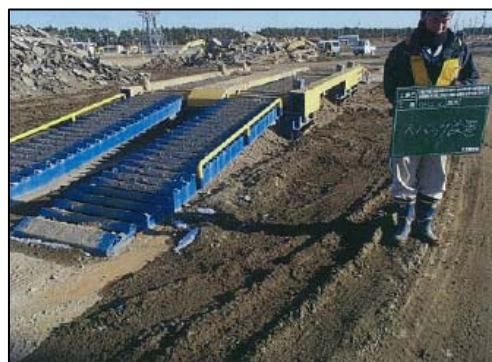
図 6-9 タイヤの泥落とし装置（スパツ）の設置 (平成 25 年 11 月 28 日)
