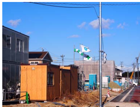
図 6-7 吹き流し設置状況 (平成 26 年 1 月 29 日)
