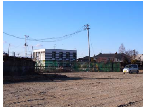
図 6-11 防塵ネット設置状況 (平成 26 年 1 月 29 日)
