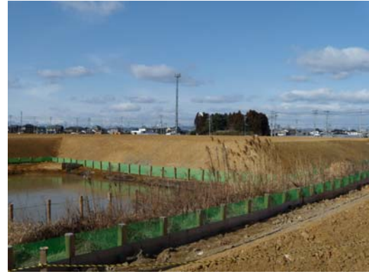
図 6-14 プレロード盛土と沈砂池 (平成 23 年 2 月 8 日撮影)
