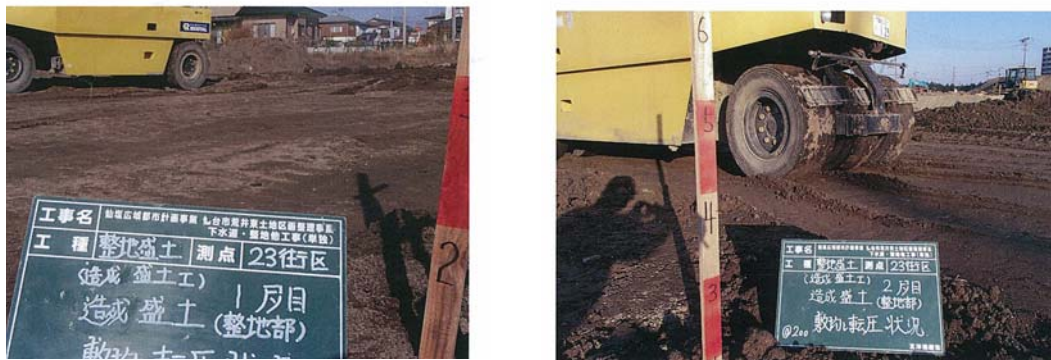
図 7.4-2 盛土敷均し転圧状況
