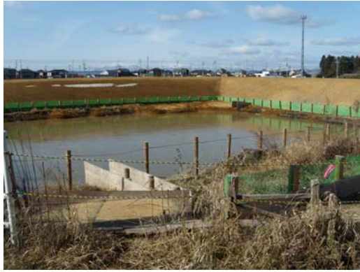
図 6-13 現復興公営住宅建設地付近沈砂池 (平成 23 年 2 月 8 日撮影)
