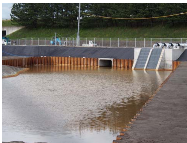
雨水貯留施設 (平成 26 年 5 月 22 日撮影)
