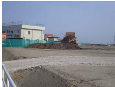
C工区-①ブロック盛土工事（平成26年5月30日撮影）
