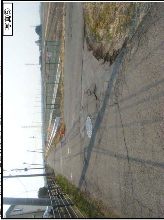
道路の陥没(市道宮前線)
