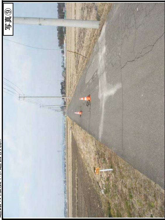
道路の陥没(市道宮前線)
