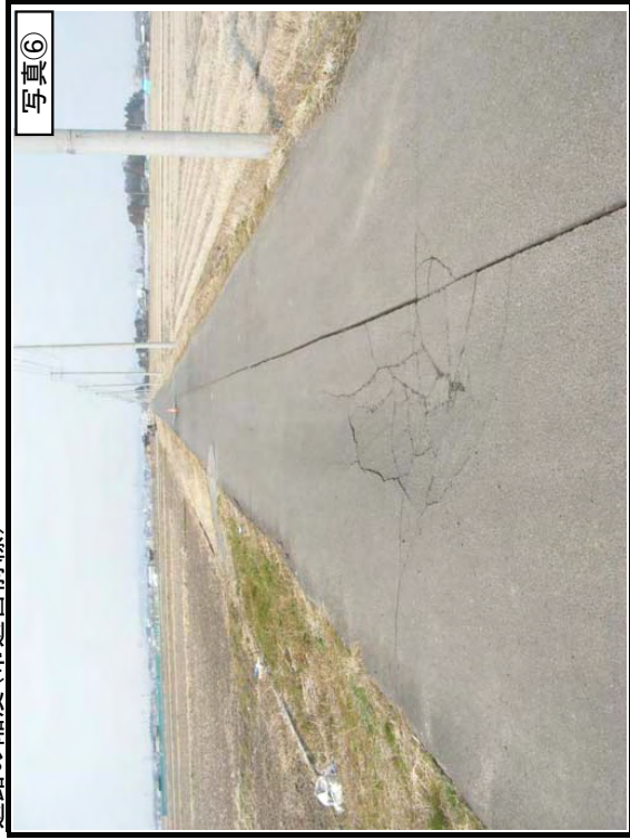
道路の陥没(市道宮前線)
