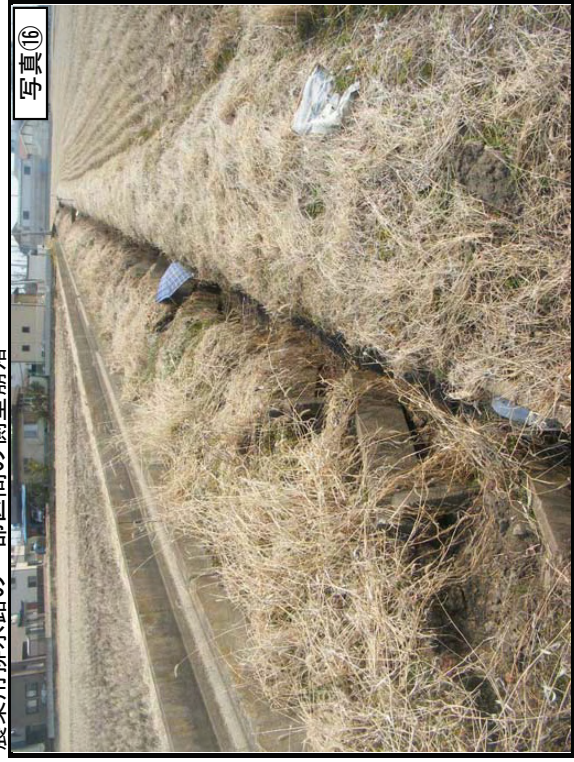
農業用排水路の一部区間の側壁崩落
