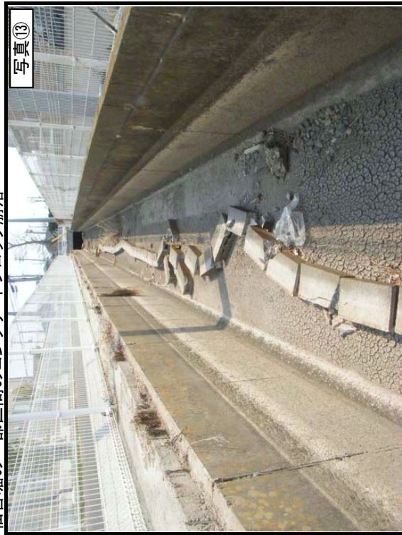
仙台堀の一部区間のコンクリートブロック崩落
