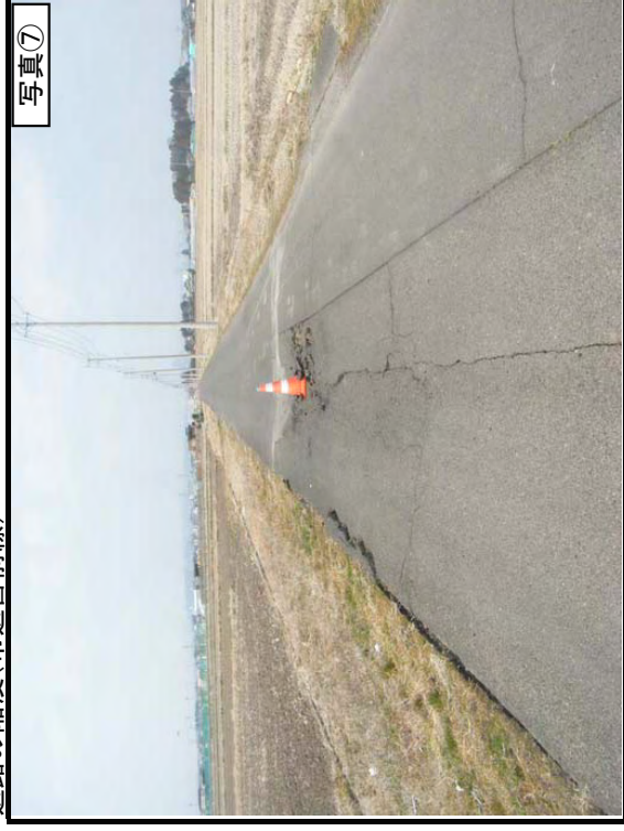
道路の陥没(市道宮前線)
