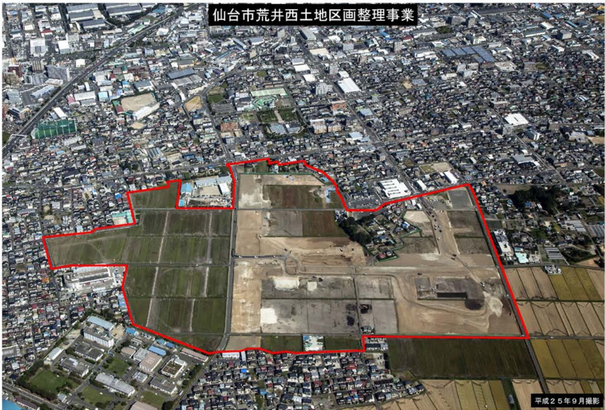
写真 2.5-1 工事の進ちょく状況(平成 25 年 9 月撮影)
