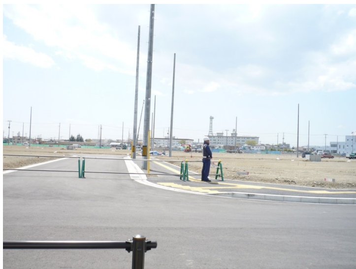
写真 6.6-4 交通整理員の配置（平成 28 年 4 月 19 日）
