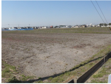
[平成 26 年 4 月 14 日撮影] 施工中
