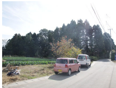
[平成 26 年 10 月 24 日撮影] 施工中
