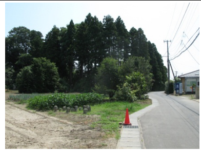
[平成 25 年 8 月 20 日撮影] 施工中
