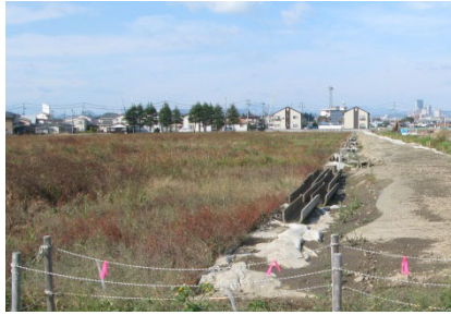
[平成 26 年 10 月 24 日撮影] 施工中（荒井西 1 号雨水幹線工事箇所）
