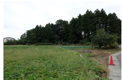
[平成 27 年 9 月 11 日撮影] 施工中
