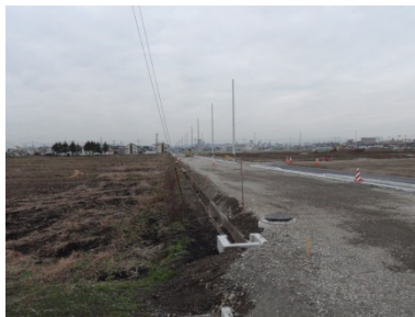
[平成 27 年 12 月 14 日撮影] 施工中（荒井西 1 号雨水幹線工事箇所）
