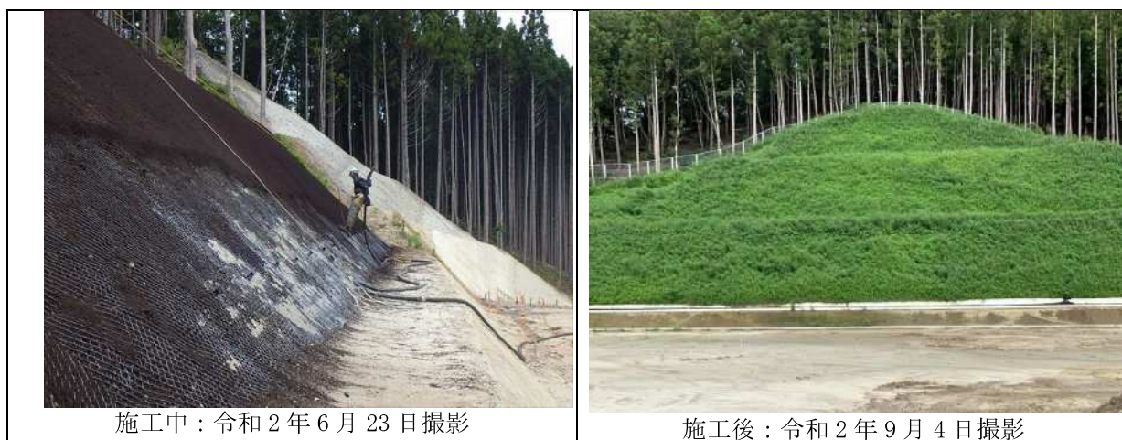
写真 8-3-1 切土法面の状況
