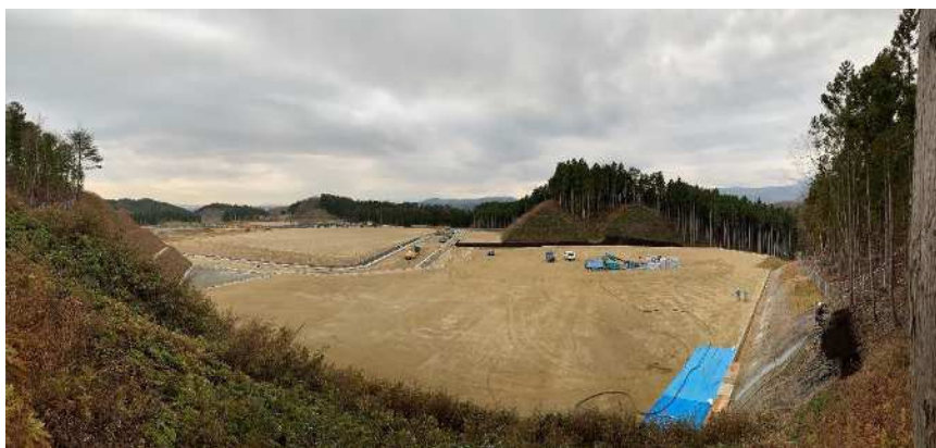
写真 5-2 第 2 期事業区域 2 工区の状況 (令和 2 年 12 月 11 日撮影)
