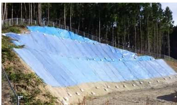
写真 6-2 濁水対策の状況（令和2年6月12日撮影）
