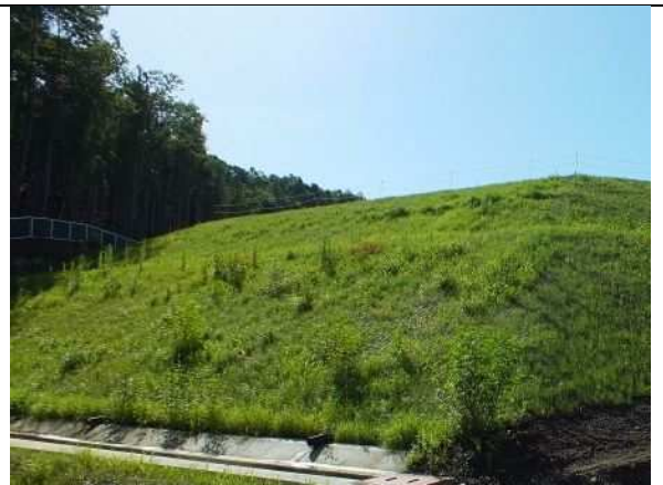
施工後：令和2年8月13日撮影
