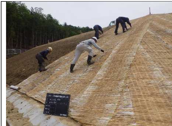
施工中：令和2年5月26日撮影
