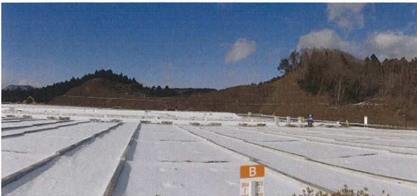
写真 5-2 第 2 期事業区域 2 工区の状況 (平成 31 年 1 月 9 日撮影)
