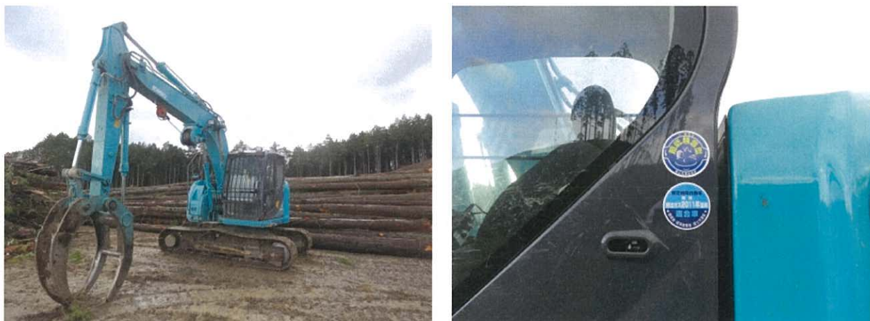
写真6-1 油圧ショベル（平成30年12月13日撮影）
