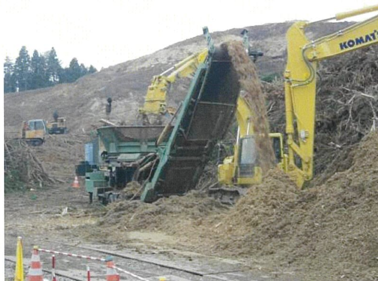
写真 8-9-3 伐採木枝条の破砕処理状況(平成 24 年 4 月 18 日撮影)
