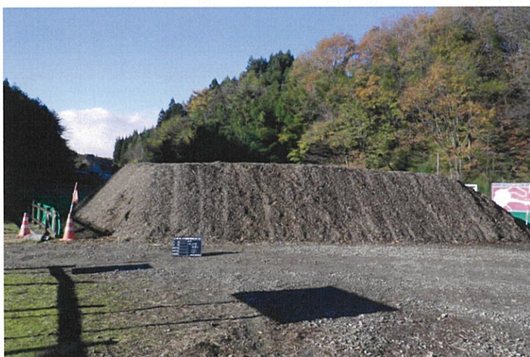
写真 8-9-6 破碎材仮置き状況(平成 24 年 11 月 20 日撮影)
