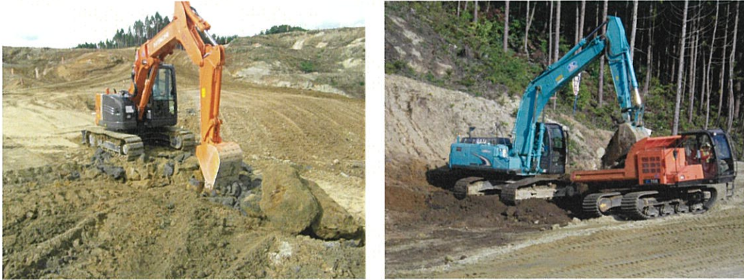
写真 8-10-1 低燃費型重機の使用状況
