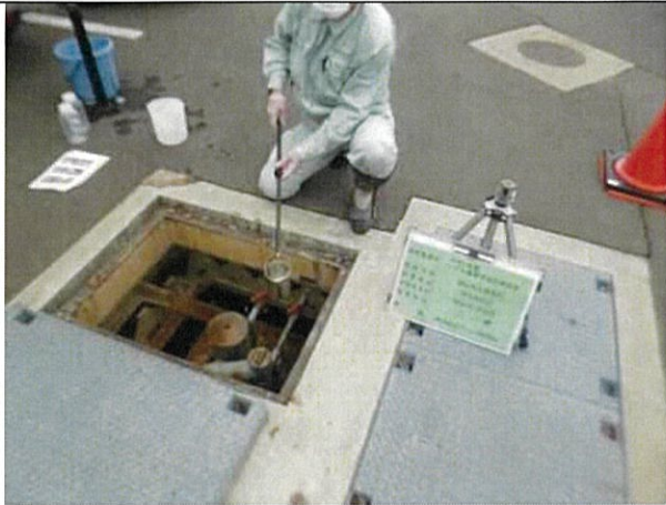
浄化槽出口：令和3年3月20日撮影
