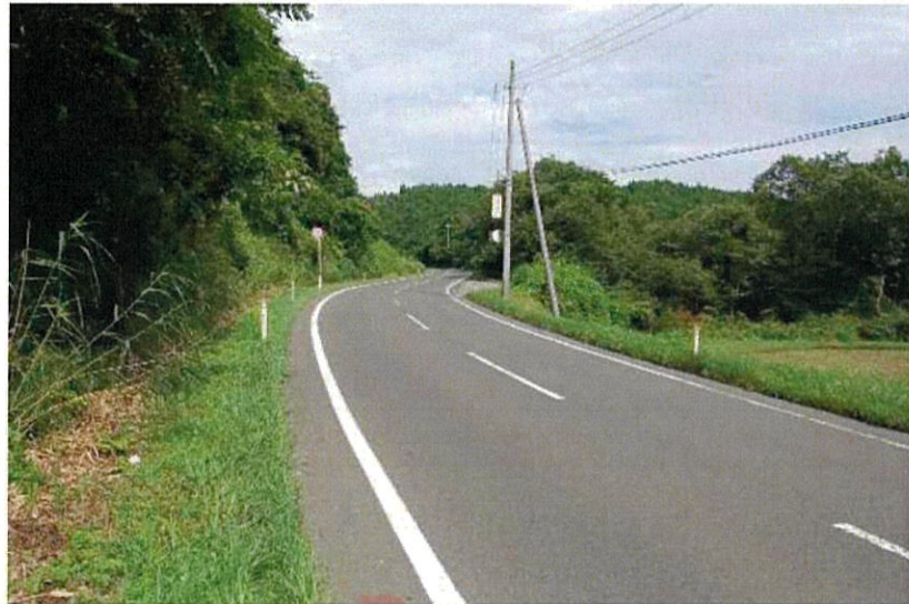
写真 8-7-11 工事前の状況(国道 457 号 : 夏季)
