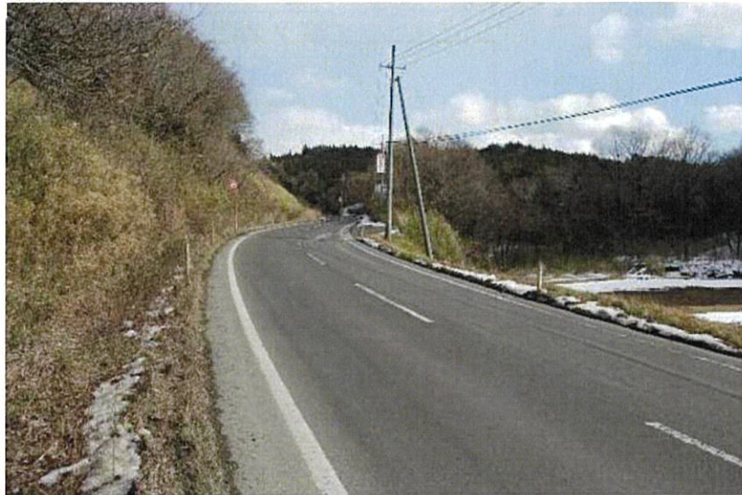
写真 8-7-14 工事前の状況(国道 457 号 : 冬季)
