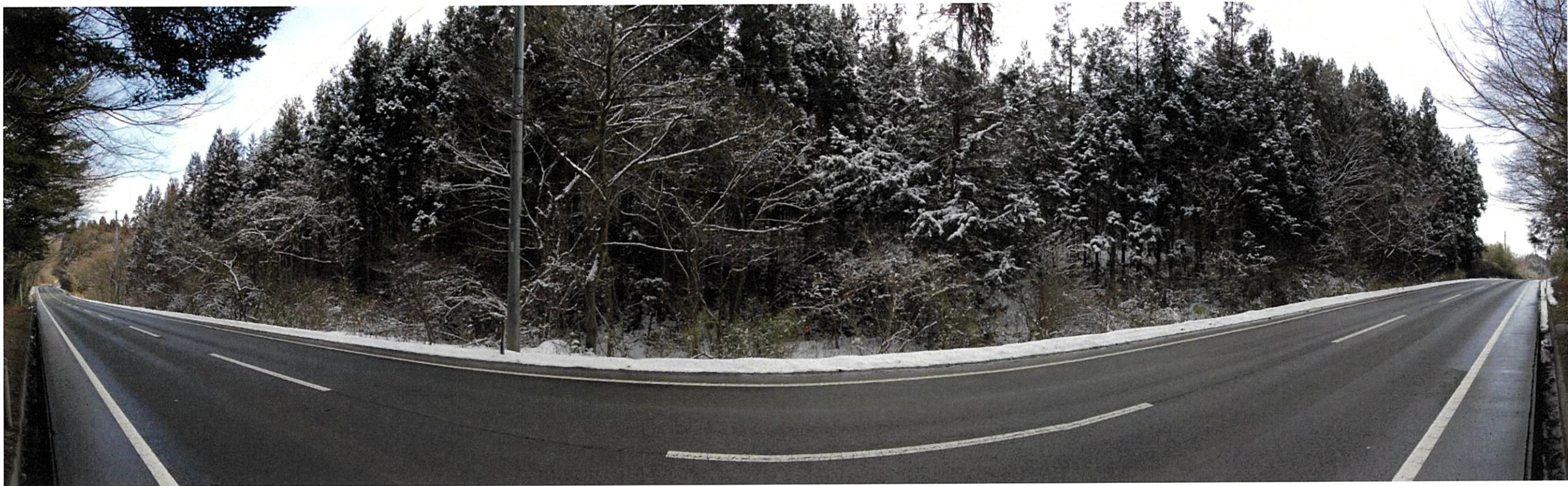
写真 8-7-33 工事前の管理用道路入り口(展葉期：冬季)
