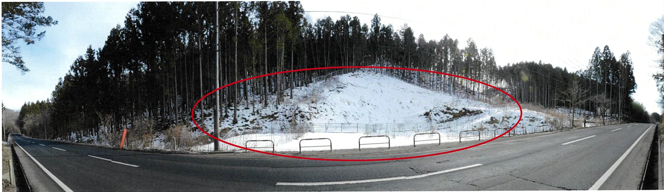
写真 8-7-34 工事後の管理用道路入り口(展葉期：夏季「ゲート着色後」)
