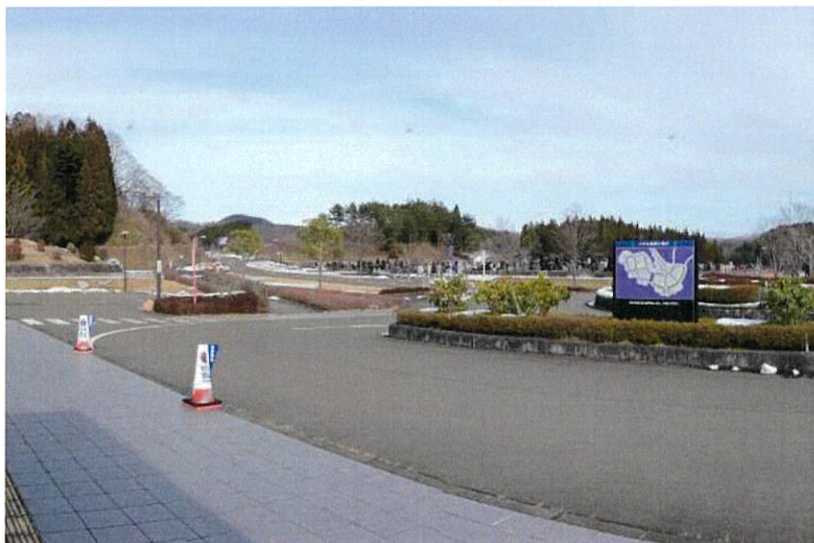
写真 8-7-26 工事後の状況(いずみ墓園管理事務所：冬季)
