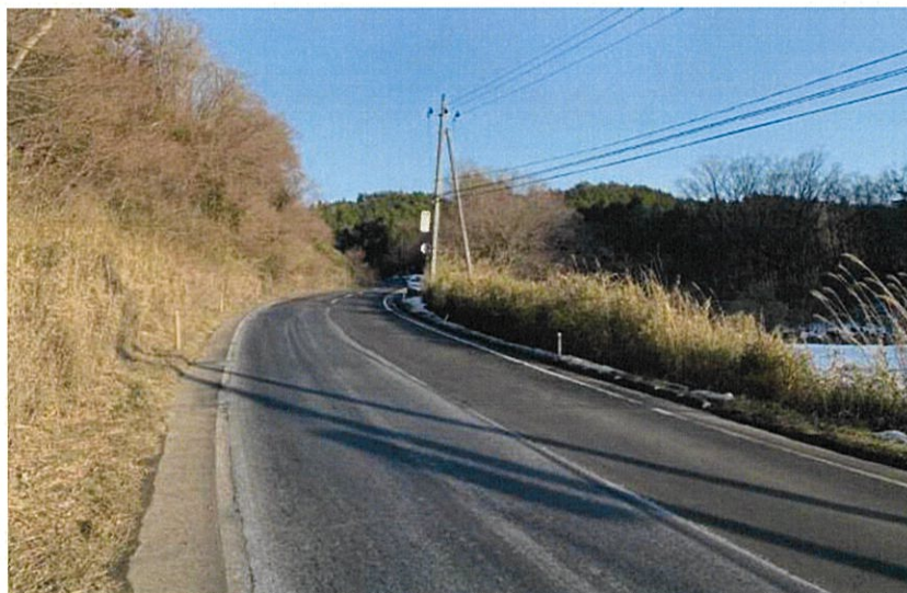
写真 8-7-16 工事後の状況(国道 457 号 : 冬季)
