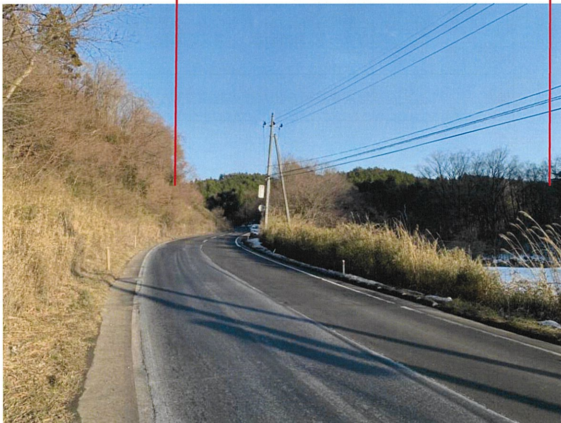
写真 8-7-20 工事前(国道 457 号 : 冬季)
