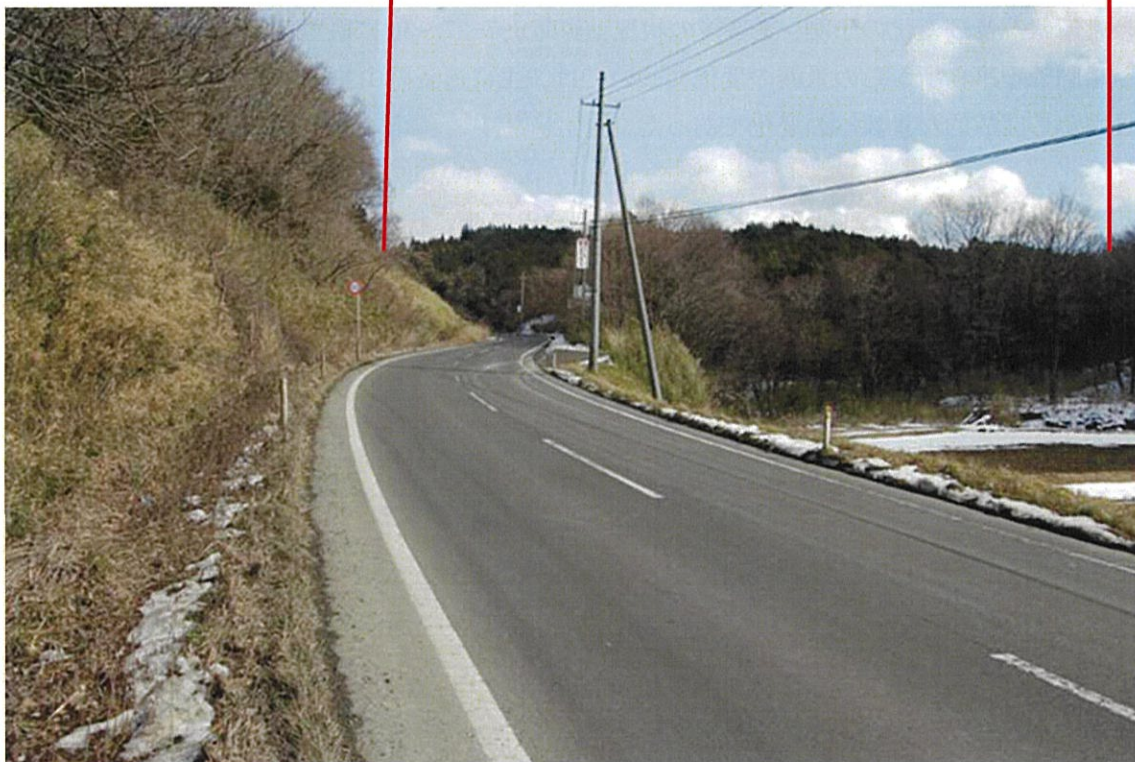
写真 8-7-19 工事前(国道 457 号 : 冬季)
