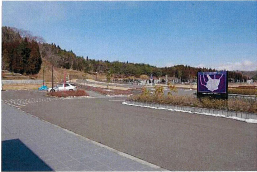
写真 8-7-24 工事前の状況(いずみ墓園管理事務所：冬季)
