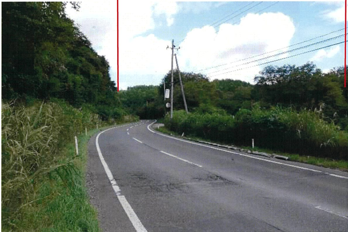
写真 8-7-18 工事後(国道 457 号 : 夏季)
