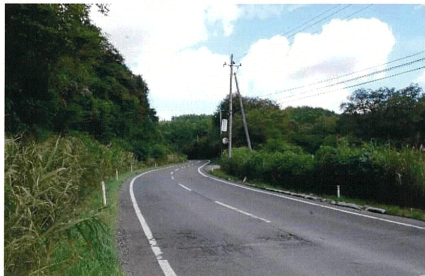
写真 8-7-13 工事後の状況(国道 457 号 : 夏季)
