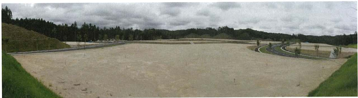
写真6-1 第2期事業区域の状況（平成26年6月1日撮影）
