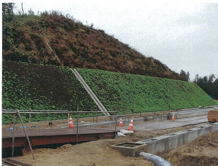
写真 7-2 切土法面の緑化状況 (平成 25 年 10 月 24 日撮影)
