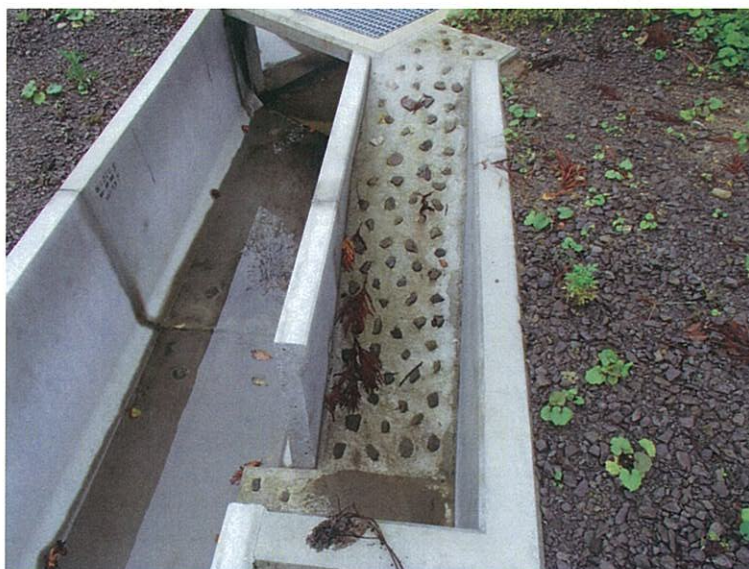
写真 7-4 環境配慮型側溝の設置状況 (平成 25 年 10 月 24 日撮影)
