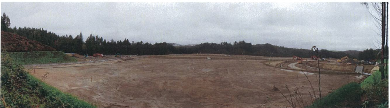
写真 6-1 第2期事業区域の状況（平成25年10月24日撮影）
