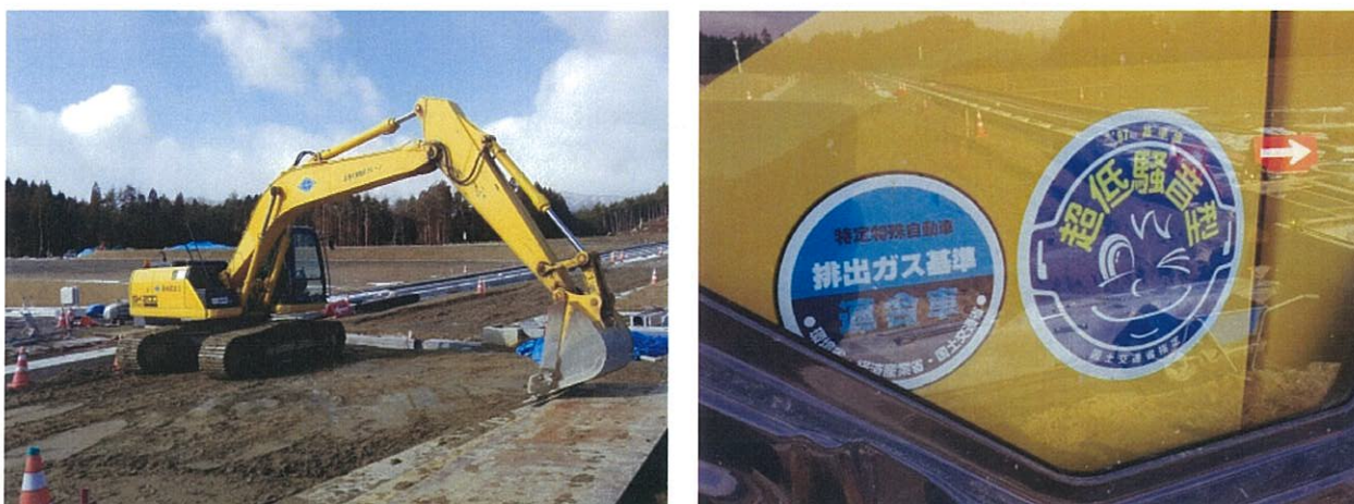
写真 7-1 現地で使用している排出ガス対策型・低騒音型建設機械
