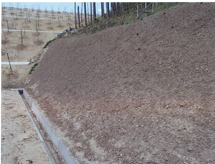
写真 7-5 破碎材の活用状況 (平成 25 年 5 月 3 日撮影)
