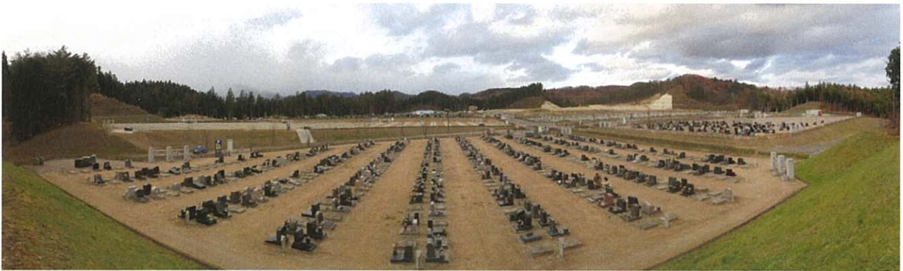
写真 5-1 第 2 期事業区域 1 工区の状況 (令和元年 11 月 29 日撮影)
