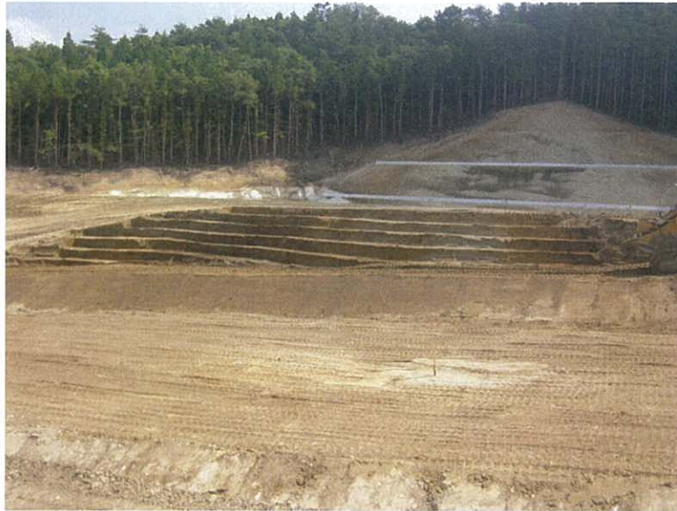
写真 8-2-1 段切り施工の状況 (令和元年 8 月 6 日撮影)
