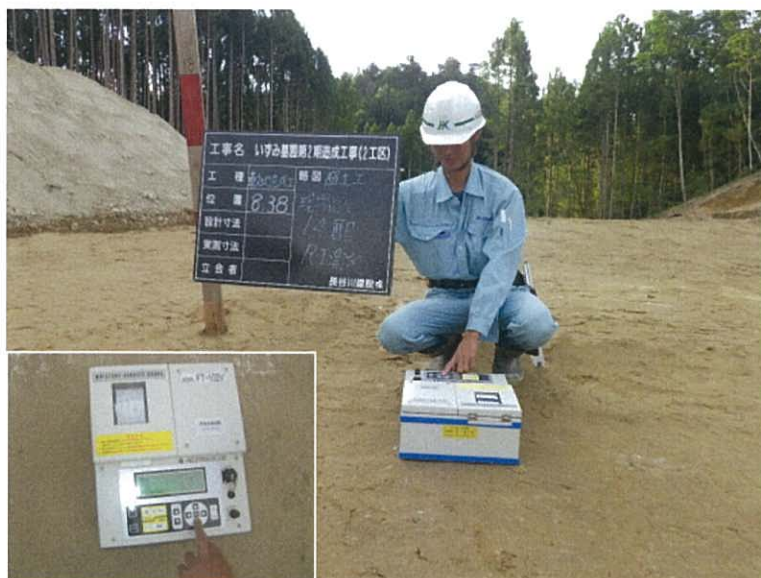
写真 8-2-4 RI 計器による密度試験の状況 (令和元年 7 月 2 日撮影)
