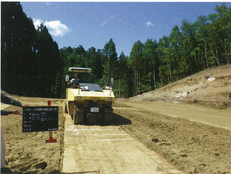
写真 8-2-3 タイヤローラーによる転圧の状況 (令和元年 5 月 30 日撮影)
