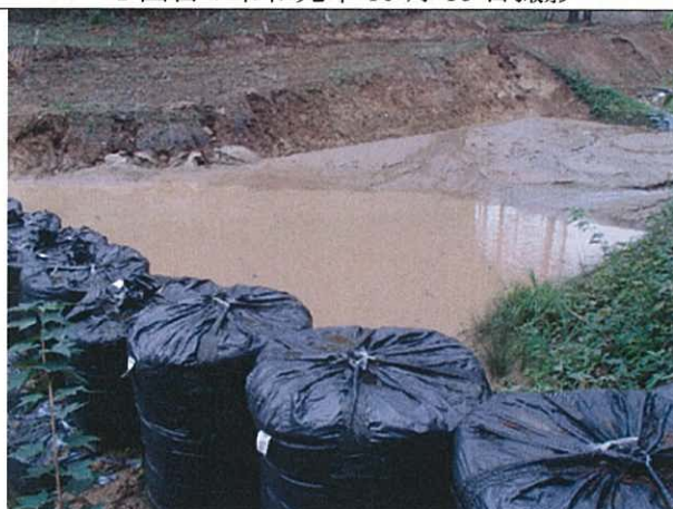
仮設沈砂池 1回目：令和元年10月8日撮影
