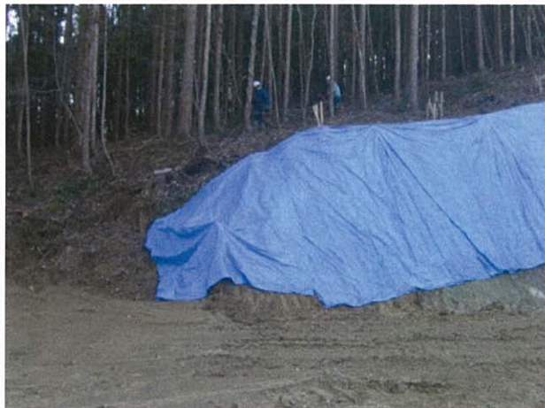
写真 6-3 濁水対策の状況
