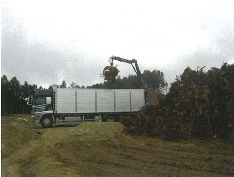
写真 8-4-3 除根材の搬出状況 (平成 31 年 3 月 7 日撮影)
