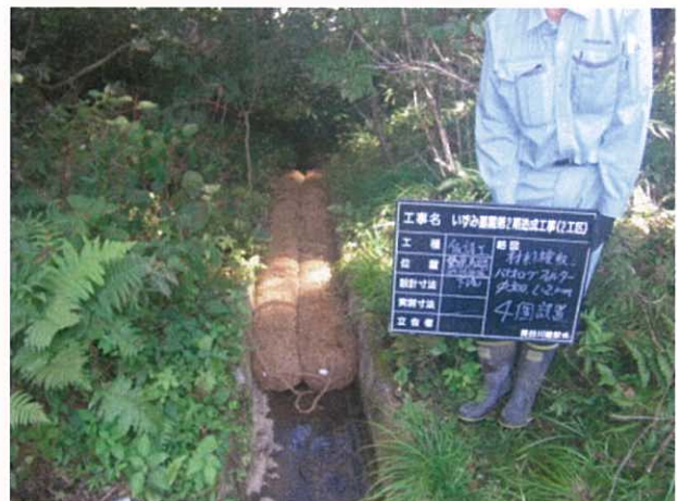
写真 6-3 濁水対策の状況
