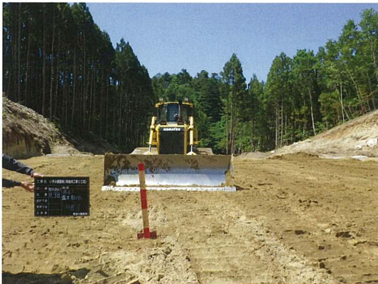
写真 8-2-2 ブルドーザーによる敷均しの状況 (令和元年 5 月 30 日撮影)
