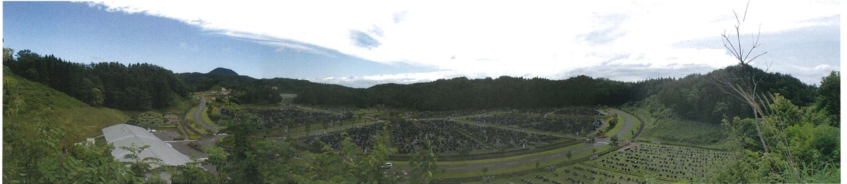
パノラマ写真 MP-1 (令和元年 6 月 17 日撮影)
