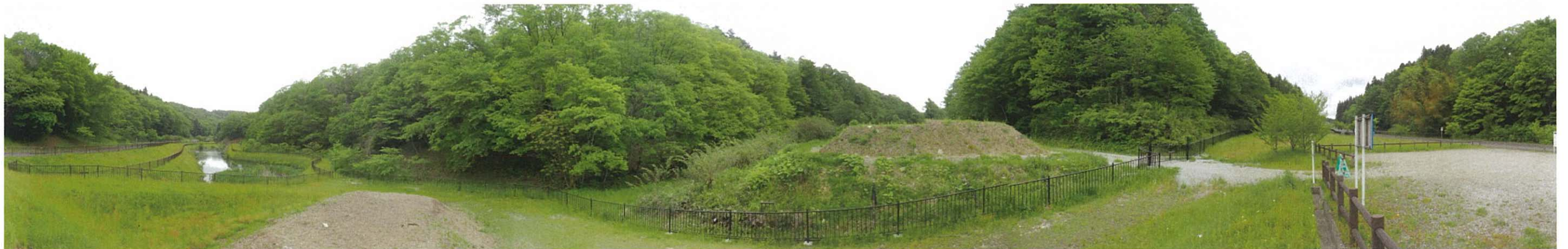
パノラマ写真 MP-2 (令和元年 5 月 20 日撮影)
