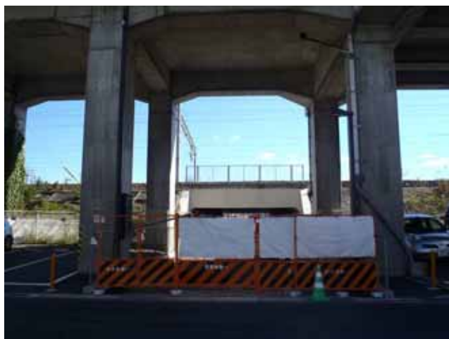
地下鉄長町一丁目アプローチ
