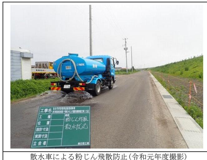
写真 6.3-1 粉じんの飛散防止対策の実施例
