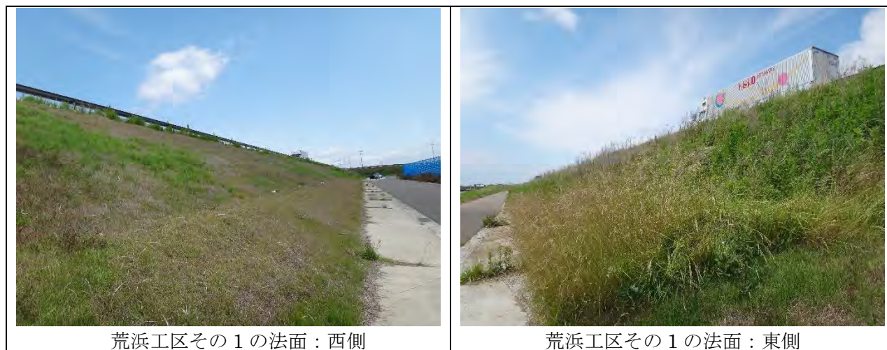
写真 8.3-18 荒浜工区（その1）の法面の状況
