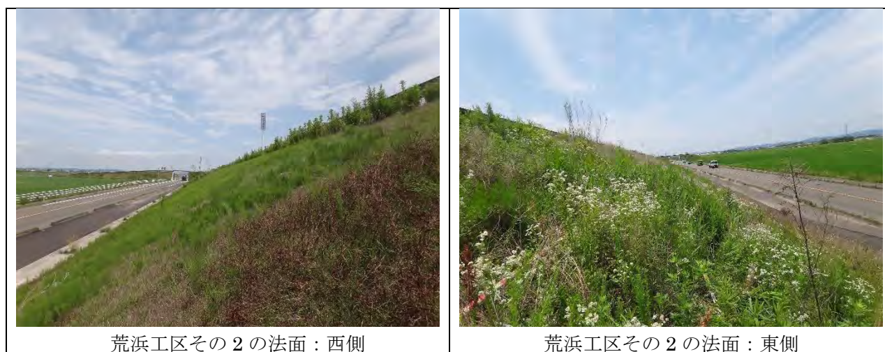
写真 8.3-19 荒浜工区（その2）の法面の状況
