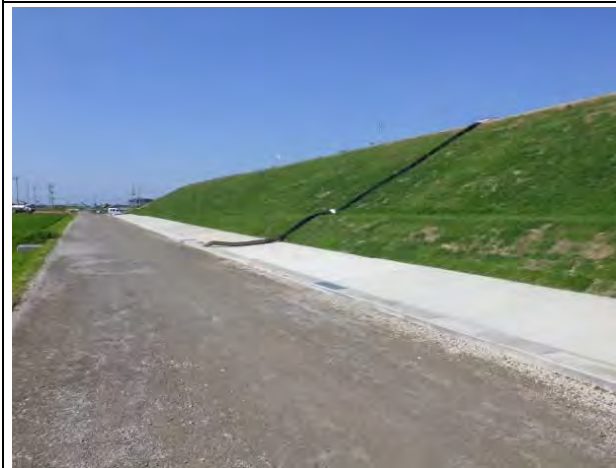
緑化後の法面の状況（平成29年度撮影）
