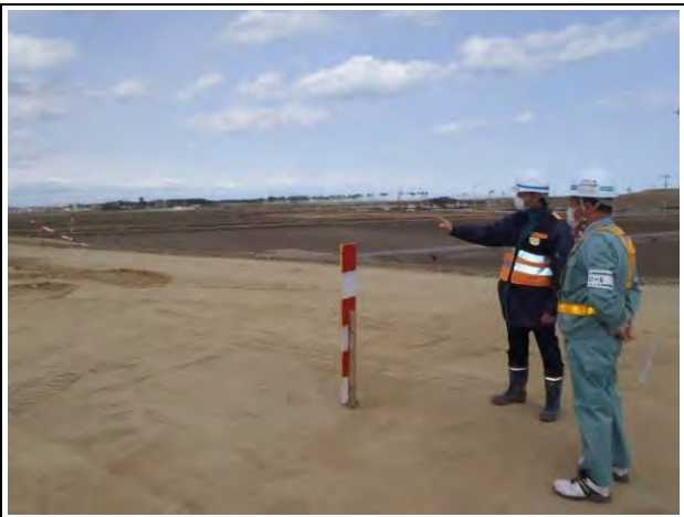
施工点検状況（平成29年度撮影）
