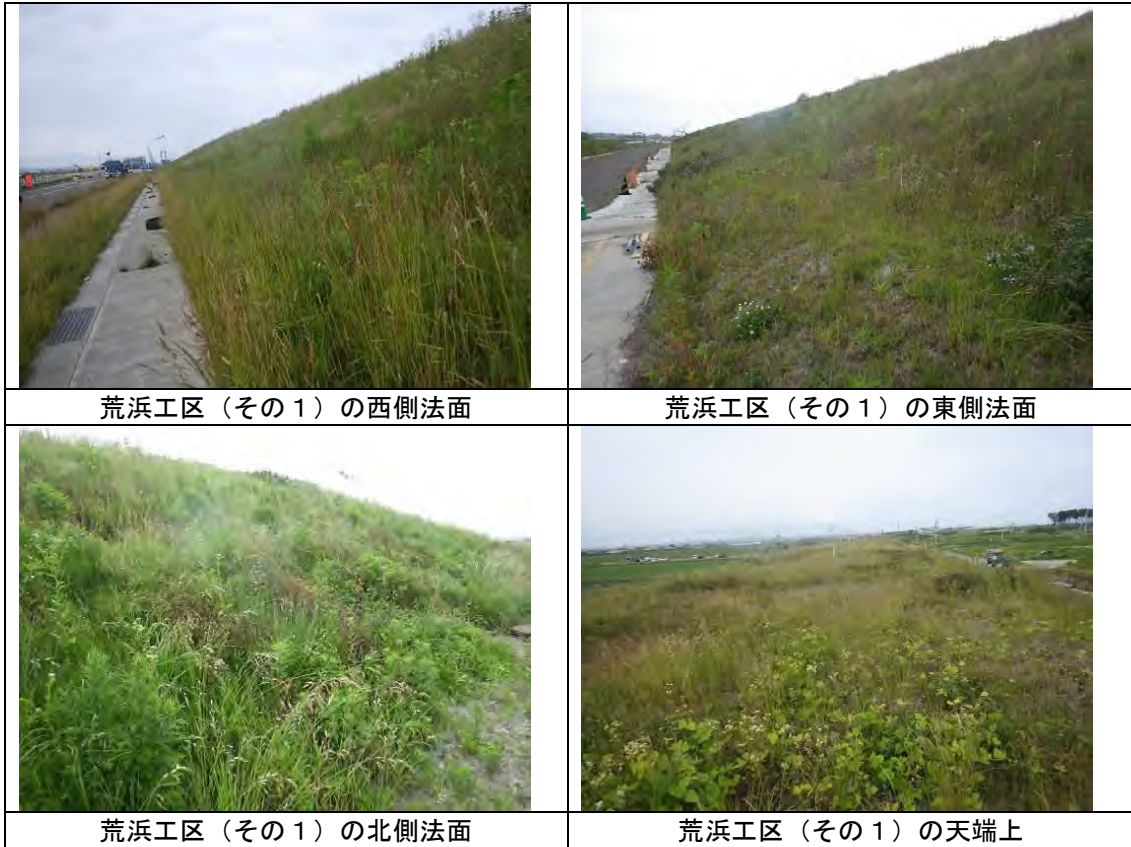
写真 8-15 荒浜工区（その1）の植生状況（平成30年6月18日撮影）
