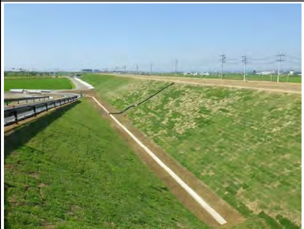
緑化後の法面の状況（平成29年度撮影）
