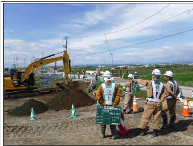
施工点検状況（平成29年度撮影）
