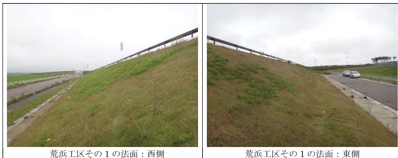
写真 8.7-5 荒浜工区（その1）の法面の状況
