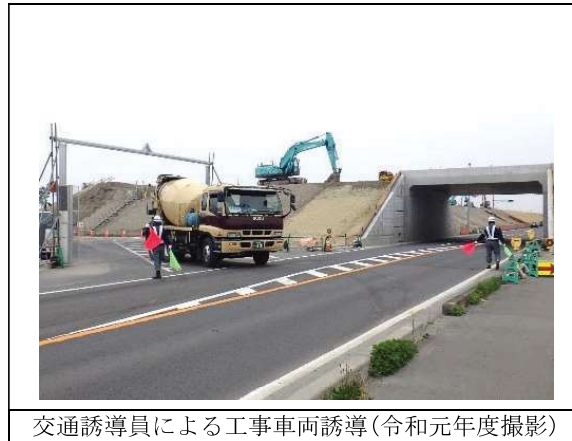
写真 8.13-3 交通誘導員の配置状況
