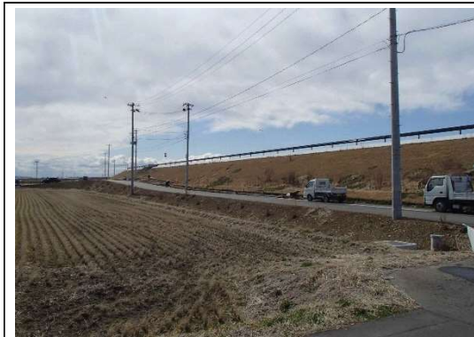
[redacted] 付帯工事状況 (令和2年3月12日撮影)
