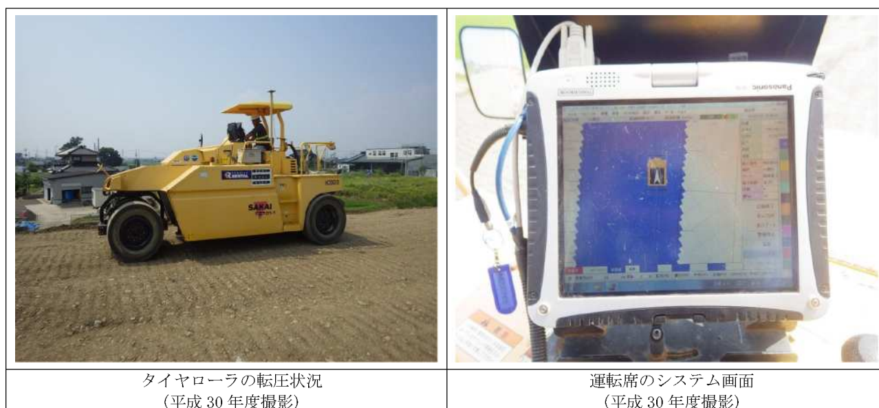
写真 6-8 転圧管理システムによる施工状況
