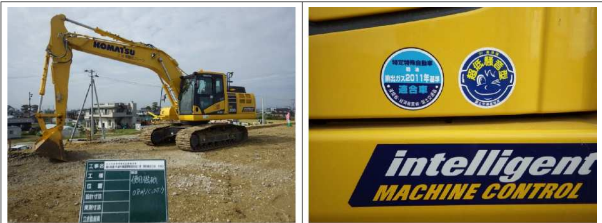
排出ガス対策型・低騒音型・省エネモードを装備したバックホウ（平成 30 年度撮影）
