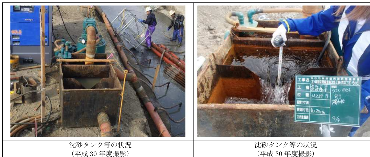
写真 6-7 沈砂タンク等の設置状況
