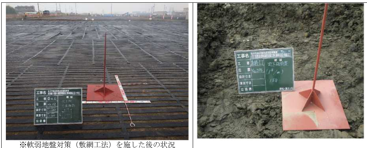
写真 7-1 沈下板の設置状況（平成 30 年度撮影）
