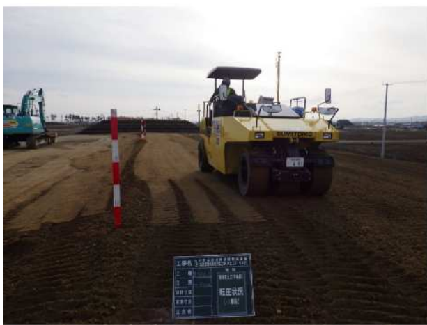
路体盛土工の転圧状況 (平成30年度撮影)
