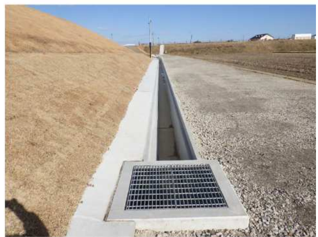
側溝の設置状況 (平成30年度撮影)
