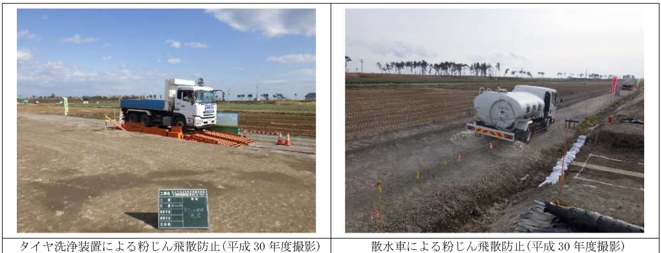
写真 6-2 粉じんの飛散防止対策の実施例
