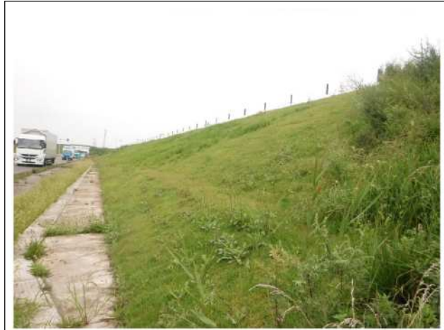
再緑化後の法面の状況 (令和元年9月撮影)
