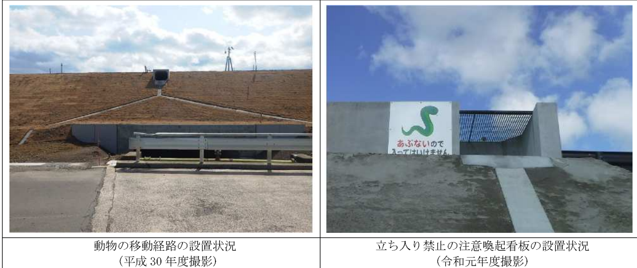
写真 6-9 動物の移動経路の設置状況（施工完了後）
