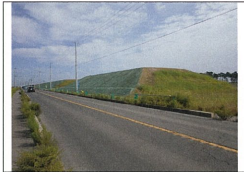
種子を散布した法面の状況 (平成 27 年 9 月撮影)
