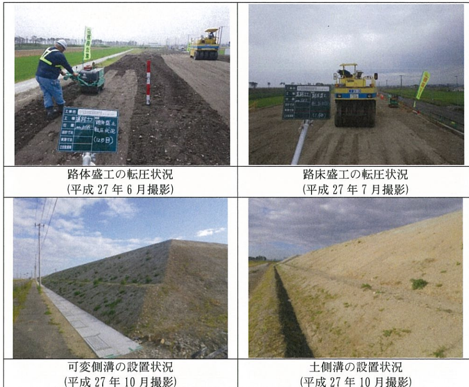
写真 6-6 盛土の締め固めの状況及び側溝の設置状況
