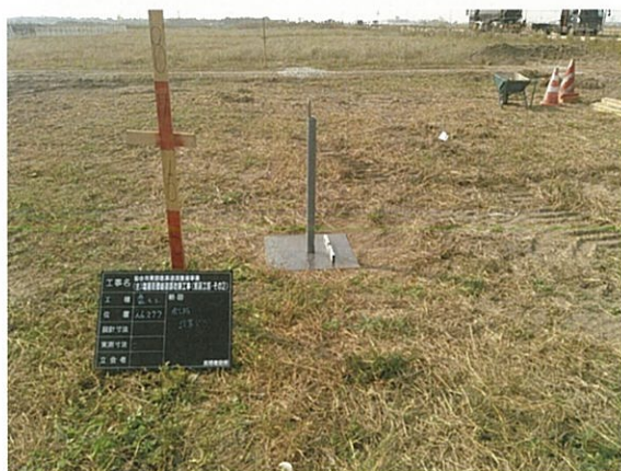
写真 8.2-1 沈下板の設置状況
