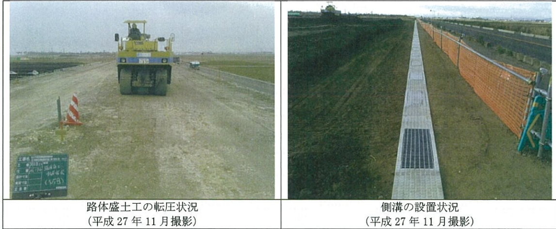
写真 6-3 盛土の締め固めの状況及び側溝の設置状況
