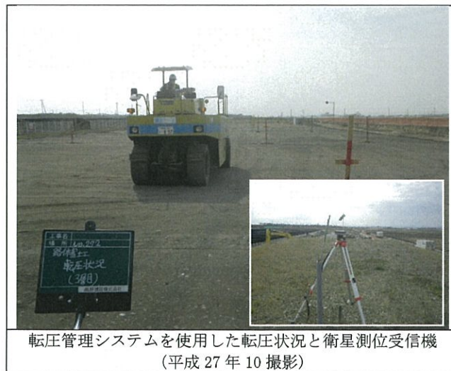
写真 6-4 効率化を図った施工状況
