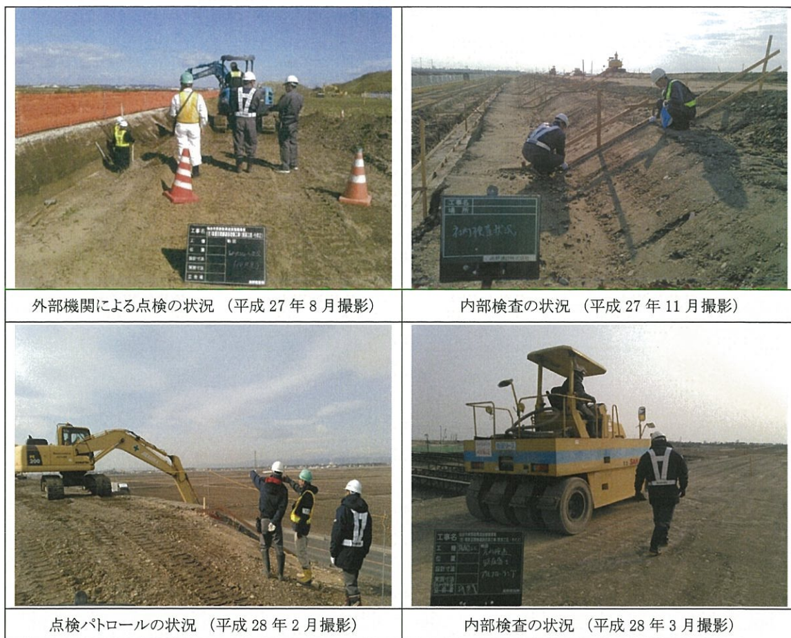
写真 8.1-1 盛土法面の点検状況
