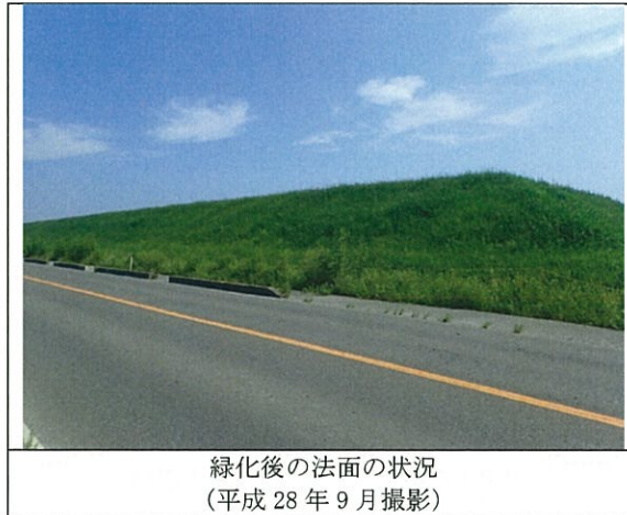
写真 6-2 緑化後の法面の状況
