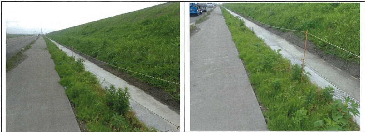
荒浜工区（その1）西側から撮影した状況 法尻にはシールコンクリートが打設されており、その西側は現道になっている。 シールコンクリートと歩道の間には植物が生育可能なスペースがある。
