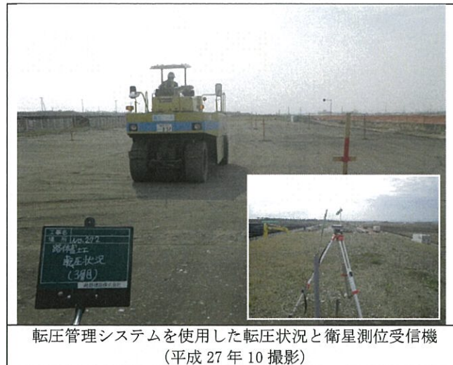
写真 8.6-2 施工の効率化のために使用した転圧管理システム
