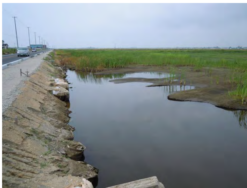
図 8.5-7 東日本大震災により陥没したと思われる農地 (平成 24 年 9 月 9 日撮影)
