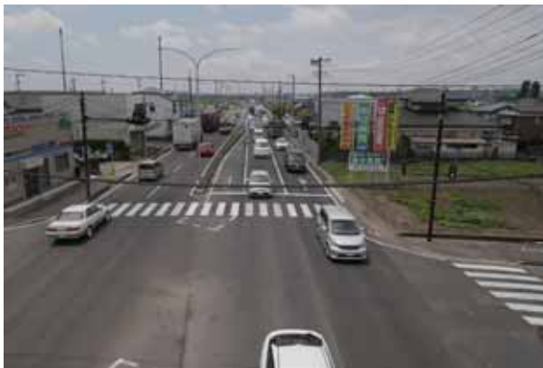
No.3 岩切歩道橋（南西方向）
