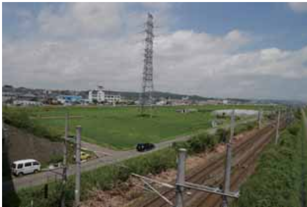
No.8 国道4号跨線橋（北方向）
